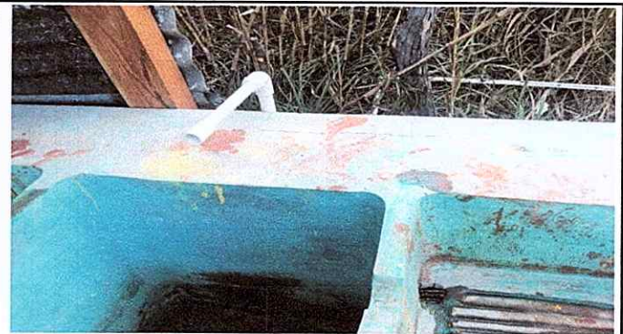
Foto 10: Sustitución de llave de chorro
