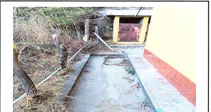
Foto 4: Reparación de cuneta de concreto
