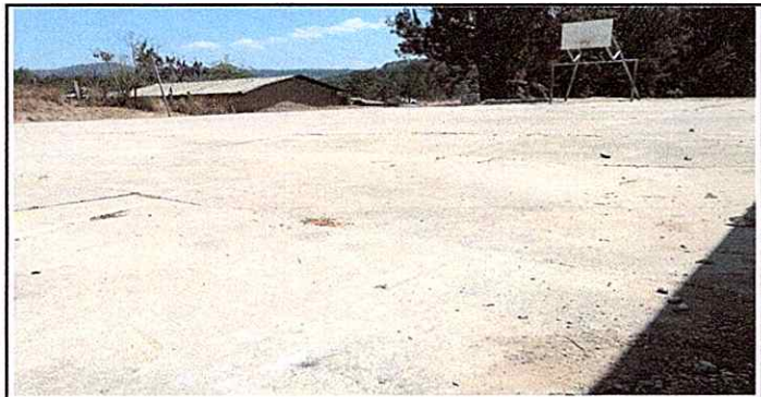
Foto 11: Reparación de plancha de concreto de patio
