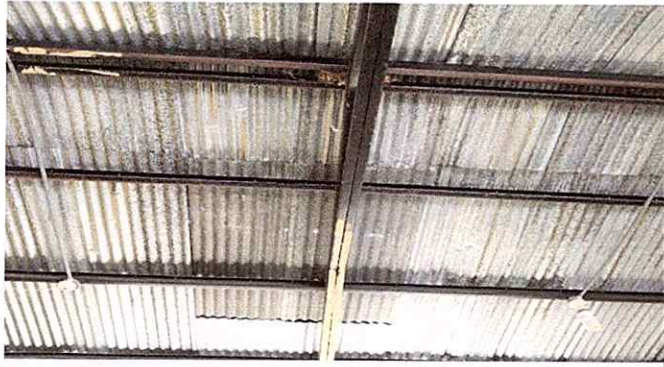
Foto7: Mantenimiento a estructura de soporte de metal
