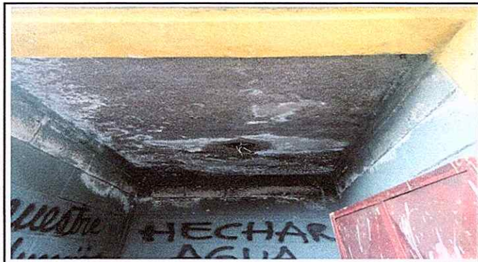
Foto 9: Impermeabilización de loza.
