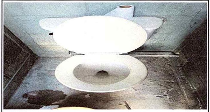
Foto 8: Sustitución de tapadera sanitario
