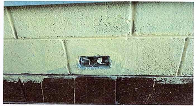
Foto 8: Sustitución de tomacorrientes dobles
