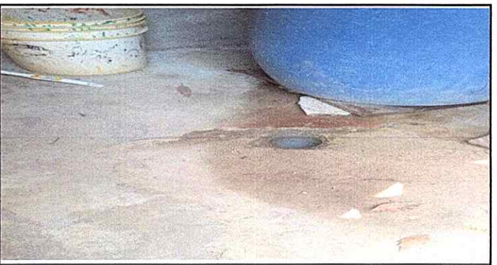
Foto 6: Sustitución de piso de torta de concreto por antideslizante
