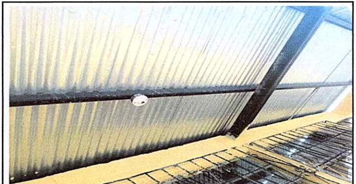
Foto 6: Sustitución de focos ahorradores
