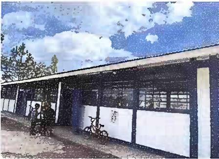
Modulo 5: sustitucion de canal pvc, pintura en muros interiores y exteriores, reparacion de banquetta de concreto, mantenimiento de puertas de metal.
