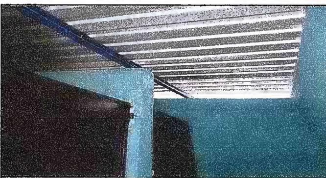
Foto 4 SUSTITUCIÓN DE LAMINA POR LAMINA TROQUELADA ALUZINC MODULO CALIBRE 26 FINALIZADO MODULO NO.1
