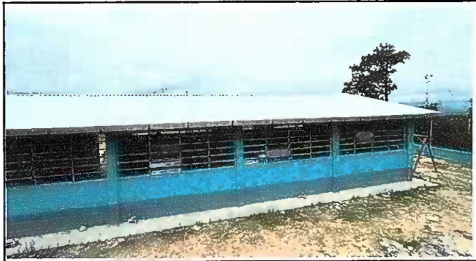
Foto1: Cambio de lámina realizado
