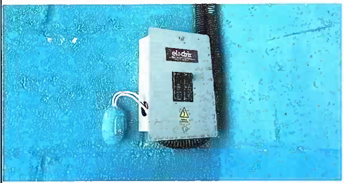
Cambio realizado en la caja eléctrica
