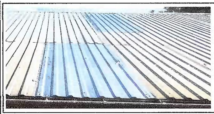
Módulo 2 : Instalación de lámina troquelada aluzink.
