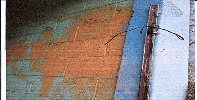
Módulo 1 Mantenimiento a estructura (lijado, cambio de tubo, cepillado, sujeción, aplicación de pintura, puerta
