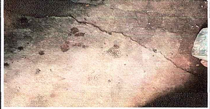
Módulo 1 Sustitución de torta de concreto.
