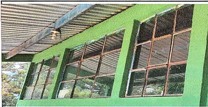
Módulo 2 Suministro e instalación de balcones en ventanas
