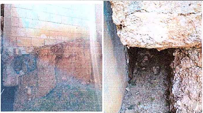
Módulo 1 Reparación de muro perimetral de block
