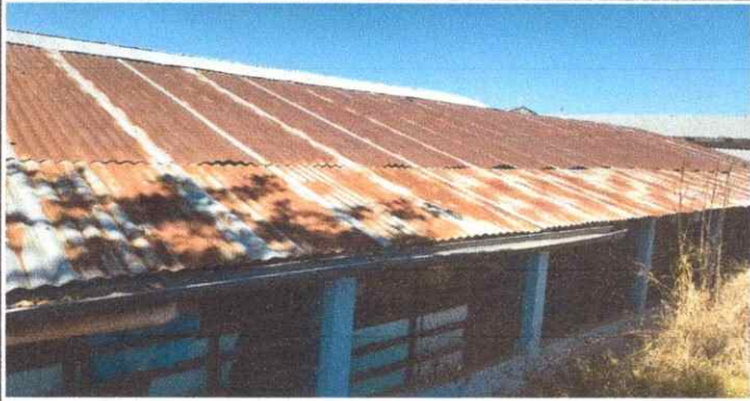
Foto 1: Sustrucción de lámina, en el primer modulo de la escuela.
