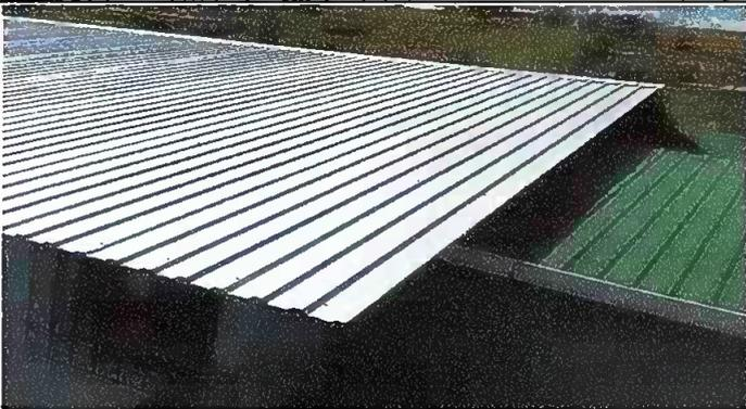
Foto 3: Lámina nueva de la mejor calidad y garantizada Aluzinc Cal.26. y estructura de soporte de metal nueva 6\*4 y de calidad.
