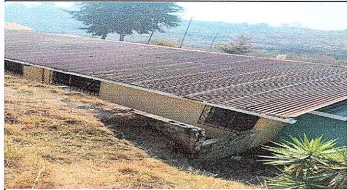
Foto1: Sustitución de laminas y elementos de fijación
