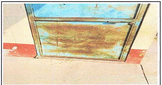
Foto 6: Mantenimiento a estructura
