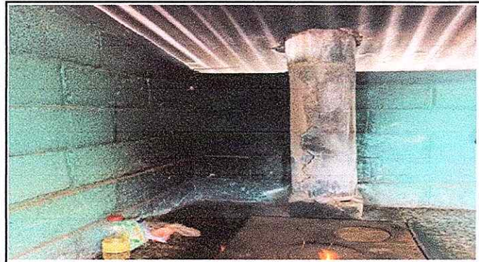
Foto 3: Sustitución de chimenea de concreto
