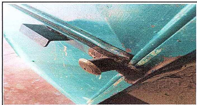
Foto 5: Sustitución de puerta
