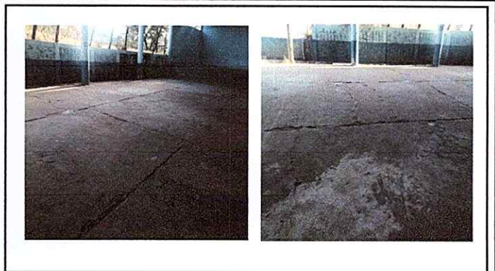
Módulo 1: Reparación plancha de cemento de patio
