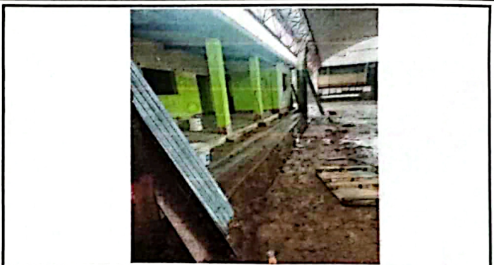
Foto 2: REPARACION DE RED DEDRENAJE Y RED DE AGUA POTABLE
