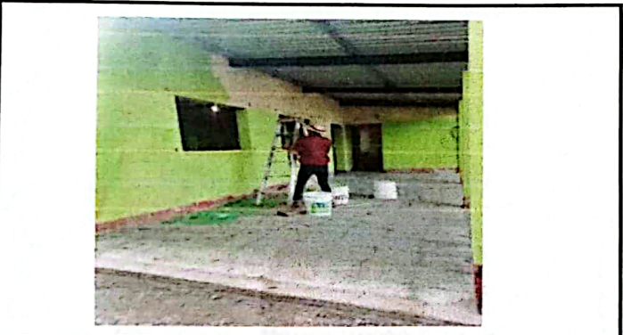
Foto 3: CUBIERTA DE LAMINA Y ESTRUCTURA DE TECHO
