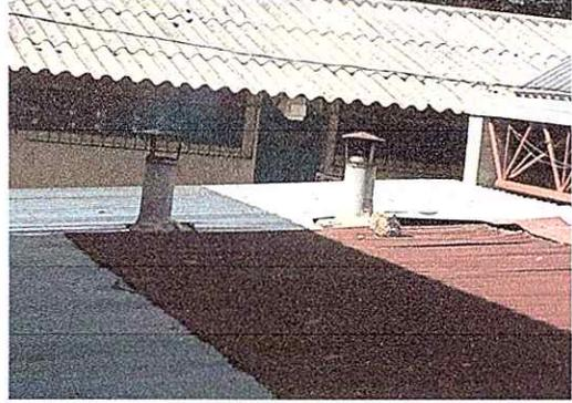
Foto 2: Sustitución de capote de lamina a lamina troquela, se coloca elementos de fijación y sustitución de estructura de soporte de metal por metal.
