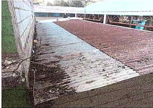
Foto1: Sustitución de lamina por lamina troquelada aluzink calibre 26
