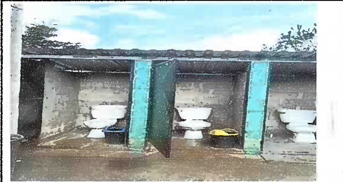
Foto 1: Reparación de muros
