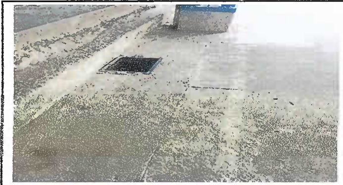
Foto 10: Mantennimiento de caja de registro
