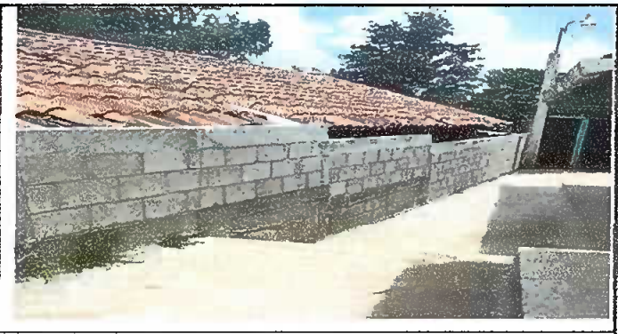
Foto 5: Sustitución de barandas de metal
