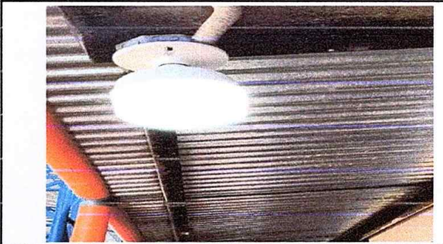
foto 10, Módulo 2: sustitucion de Focos
