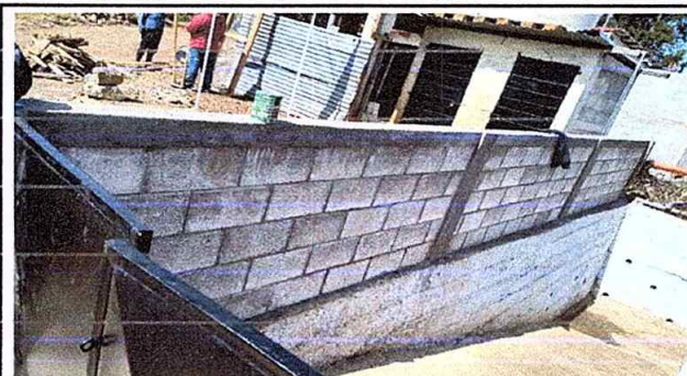
Foto 14, Muro Perimetral: Reparacion de Muro Perimetral
