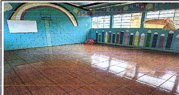
Foto 3, Módulo 1: Sustitución de piso cerámico
