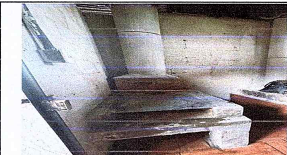
Foto 6, Módulo 2: Sustitución de plancha de metal de 3 hornillas
