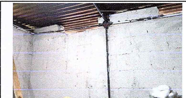
Foto 12, Módulo 2: Reparacion de Cableado Electrico
