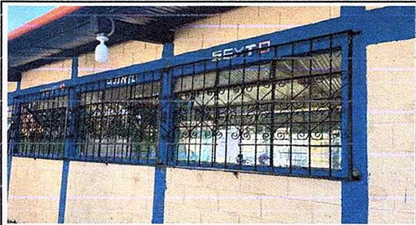
Foto 2, modulo 1: suministro e instalacion de balcon de hierro en ventana
