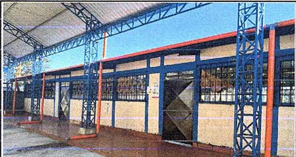
Foto 4, Módulo 1: Reparación de bajada de agua pluvial. tubo PVC 3"
