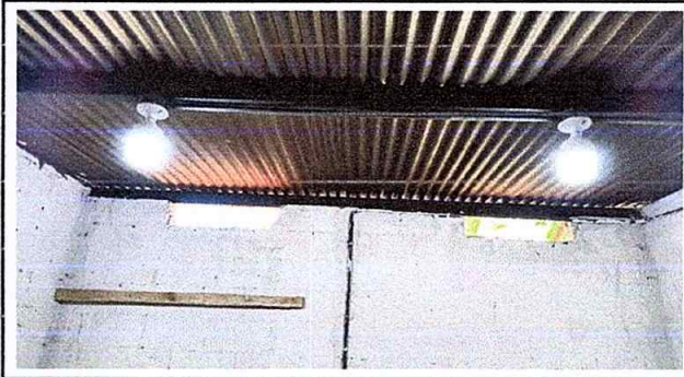
Foto 8, modulo 2: Instalacion de unidades de Luz
