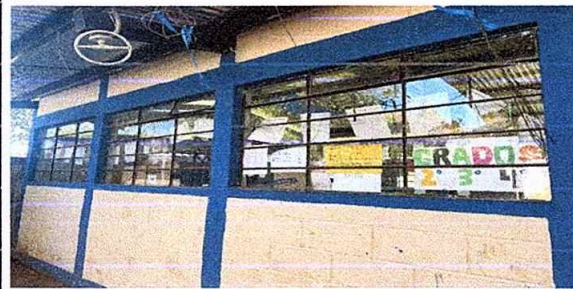
Foto 2, modulo 1: suministro e instalacion de balcon de hierro en ventana
