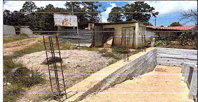
Foto 14, Muro Perimetral: Reparacion de Muro Perimetral
