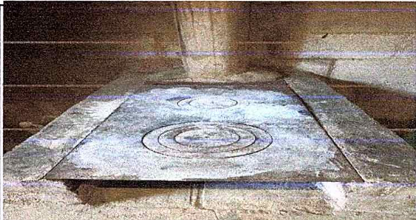
Foto 6, Módulo 2: Sustitución de plancha de metal de 3 hornillas
