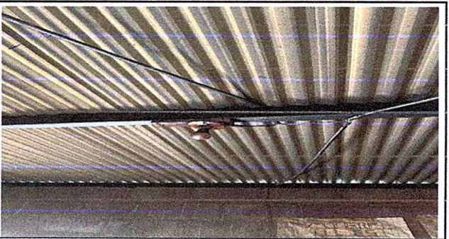
Foto 12, Módulo 2: Reparacion de Cableado Electrico
