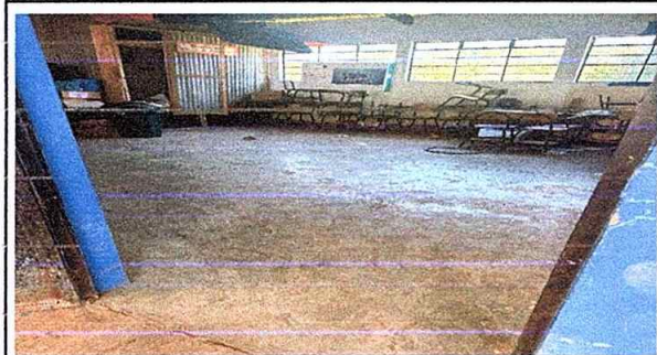
Foto 3, Módulo 1: Sustitución de piso cerámico
