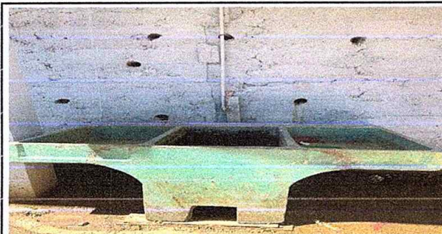
Foto 17, Áreas Exteriores: sustitución de pila de dos lavaderos
