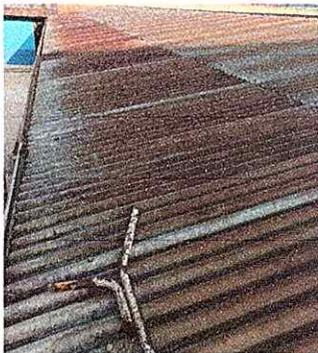
MODULO 1 Sustitución de lámina troquelada aluzinc calibre 26
