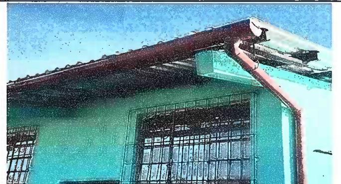
Foto 2: Mantenimiento de líneas de canal y bajadas de aguas pluviales.
