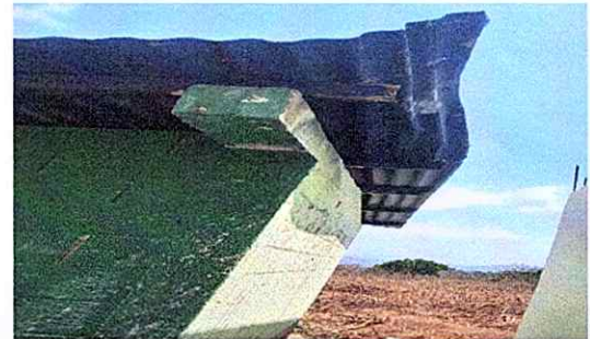
Foto 6: Desinstalacion de lamina existente e Instalación de lamina troquelada calibre 26
