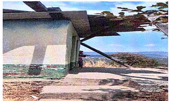
Foto 12: Desinstalacion de lamina existente e instalacion de lamina troquelada calibre 26.
