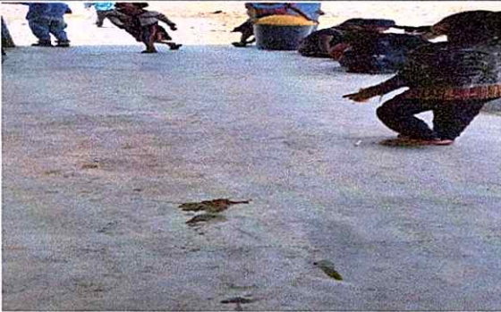
Foto 5: Colocación de piso ceramica
