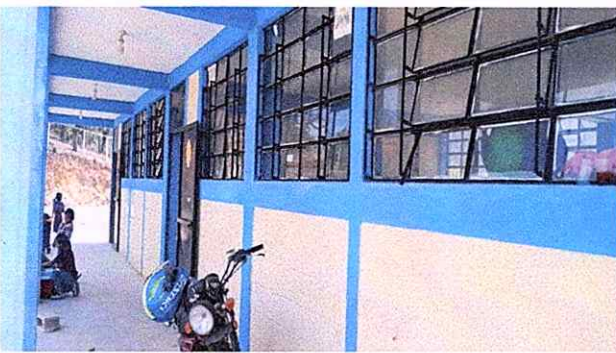
Foto 3: Instalacion de balcones en ventanas de aulas
