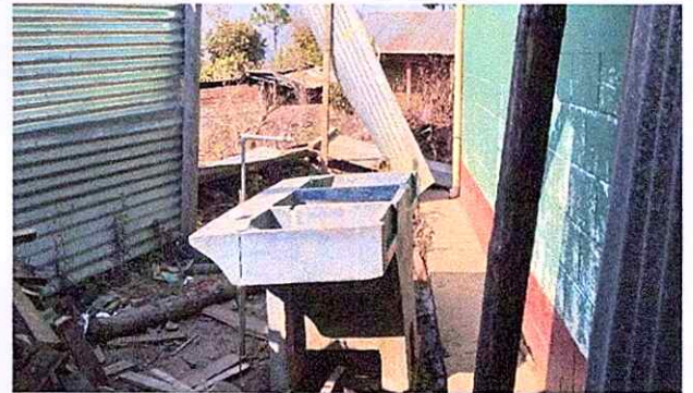
Foto 10: Sustitucion e instalacion de pila concreto cemento
