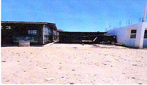
Foto 7: Instalacion de estructura soporte metal.
