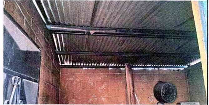
Foto 8: Desinstalacion de lamina e Instalacion de lamina troquelada calibre 26.
