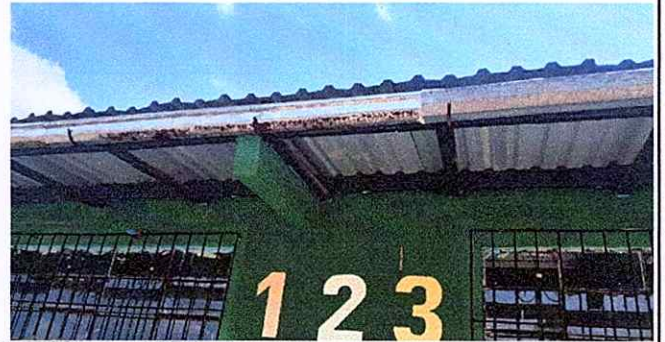
Foto 2: mantenimiento de líneas de canal y bajadas de agua pluviales
