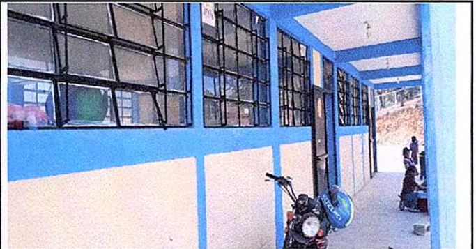
Foto 4: Aplicación de pintura en interior y exterior de aula
