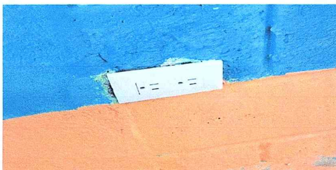
Foto 11. Módulo 1: Finalización de sustitución de tomacorrientes.
