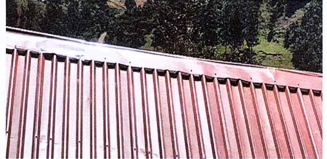
Foto 14. Módulo 2: Finalización de sustitución de capote de lámina por capote de lámina troquelada.
