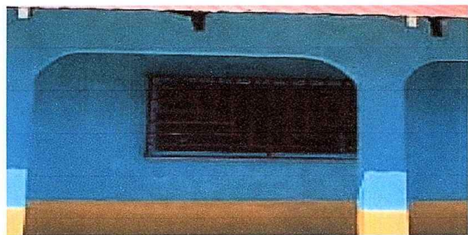
Foto 17. Módulo 2: Finalización de instalación de balcon de metal.
