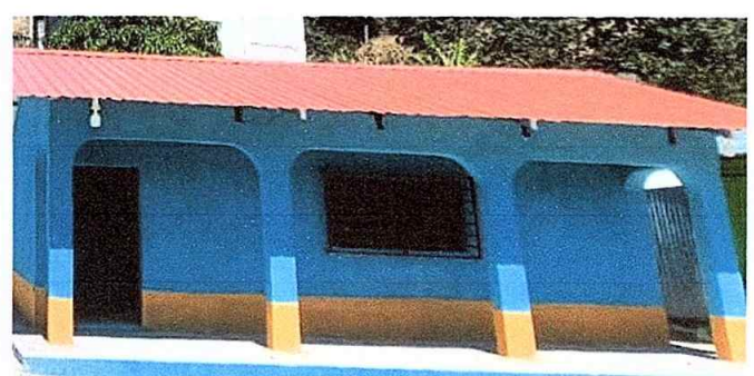
Foto 12. Módulo 2: Finalización de sustitución de lámina por lámina troquelada.
