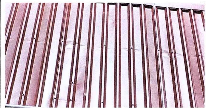
Foto 4. Módulo 1: Finalización de sustitución de elementos de fijación (tornillos).
