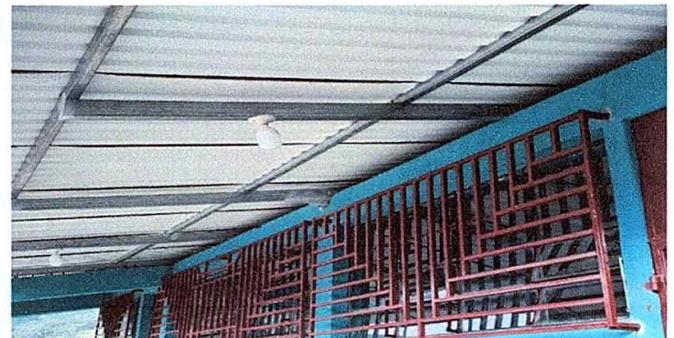
Foto 8. Módulo 1: Finalización de sustitución de focos ahorradores.
