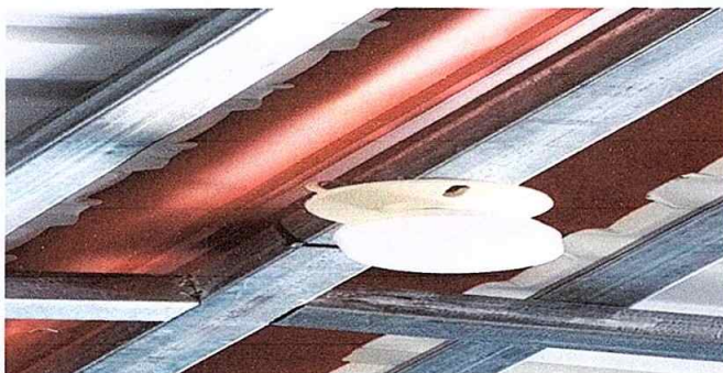
Foto 9. Módulo 1: Finalización de sustitución de plafonera.
