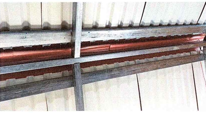
Foto 3. Módulo 1: Finalización de sustitución de capote por capote para lámina troquelada.
