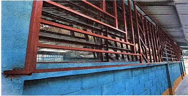
Foto 7. Módulo 1: Finalización del cambio de balcones de metal.
