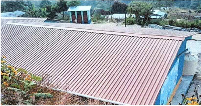
Foto 1. Módulo 1: Finalización de sustitución de lámina por lámina troquelada.
