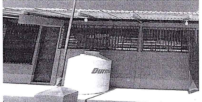
Foto 22: Finalización de pintura de muros interiores y exteriores.
