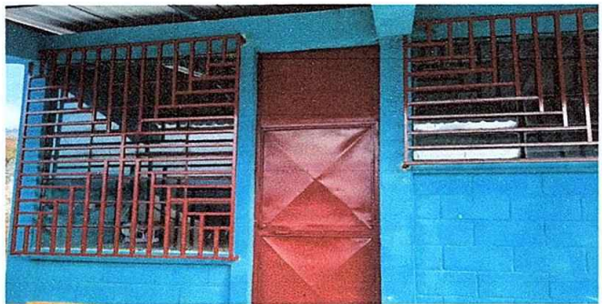
Foto 5. Módulo 1: Finalización de instalación de balcones de metal.
