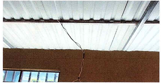
Foto 16. Módulo 2: Finalización de reparación de cableado.
