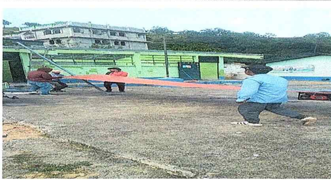
Foto 1. Módulo 1. Sustitución de lámina por lámina troquelada.
