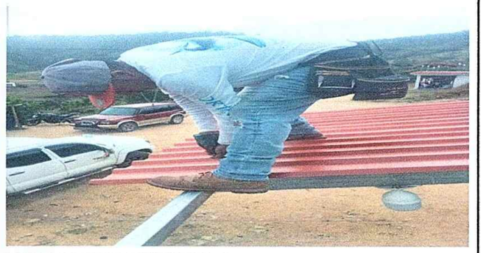
Foto 4. Módulo 1: Sustitución de elementos de fijación (tornillos).
