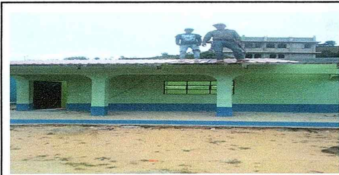
Foto 11. Módulo 2: Sustitución de lámina por lámina troquelada.
