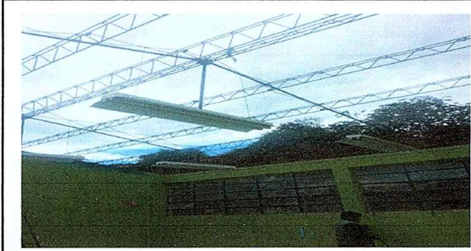
Foto 7. Módulo 1: Sustitución de ducto eléctrico.
