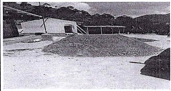
Foto 20. Módulo 3: Reparación de torta de concreto.
