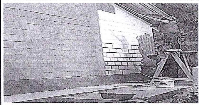
Foto 22. Pintura de muros interiores y exteriores.
