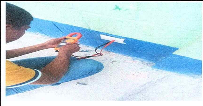
Foto 10. Módulo 1: Sustitución de tomacorrientes.
