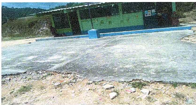
Foto 21. Módulo 3: Reparación de torta de concreto.
