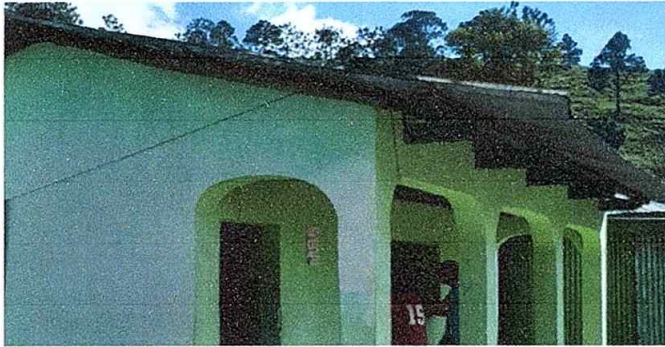
Foto 13. Módulo 2: Sustrucción de estructura de soporte de metal por metal.
