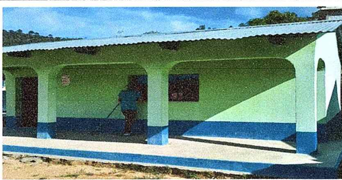
Foto 23: Pintura de muros interiores y exteriores.
