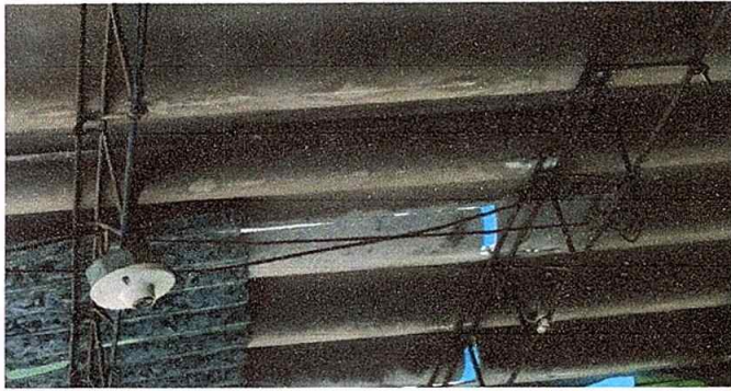
Foto 7. Módulo 1: Sustitución de ducto eléctrico.
