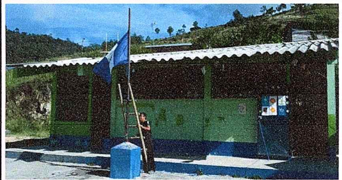
Foto 22: Pintura de muros interiores y exteriores.
