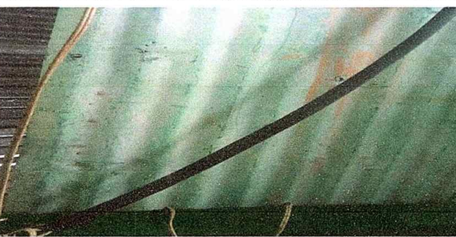
Foto 17. Módulo 2: Sustrucción de ducto eléctrico.
