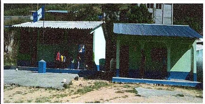
Foto 24: "Pintura de muros interiores y exteriores.
