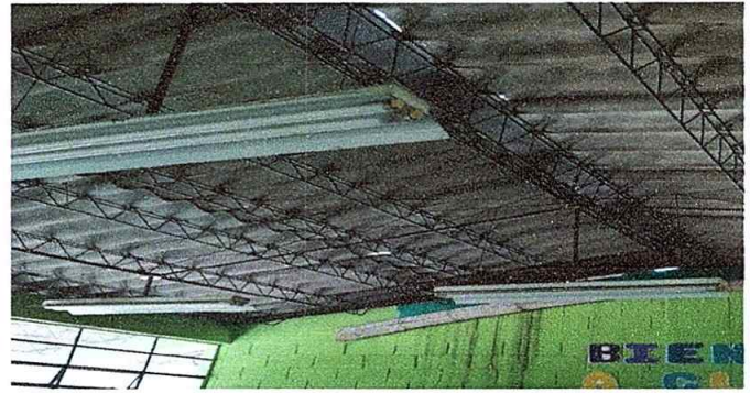
Foto 8. Módulo 1: Sustitución de focos ahorradores.
