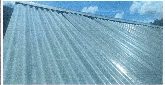
Foto 14. Módulo 2: Sustrucción de capote de lámina por capote de lámina troquelada.
