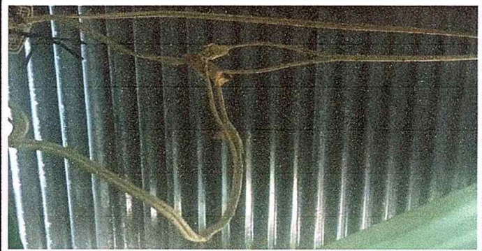
Foto 16. Módulo 2: Reparación de cableado.
