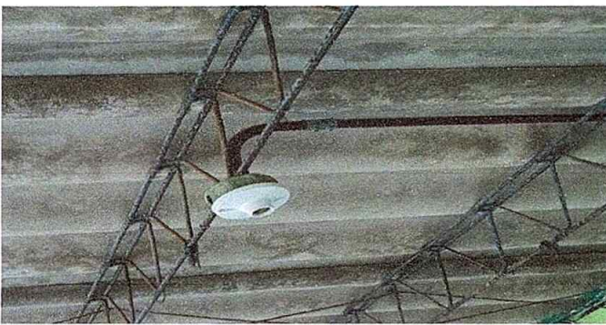
Foto 9. Módulo 1: Sustitución de plafoneras.
