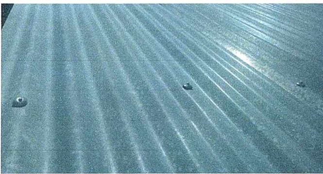
Foto 15. Módulo 2: Sustrucción de elementos de fijación (tornillos).
