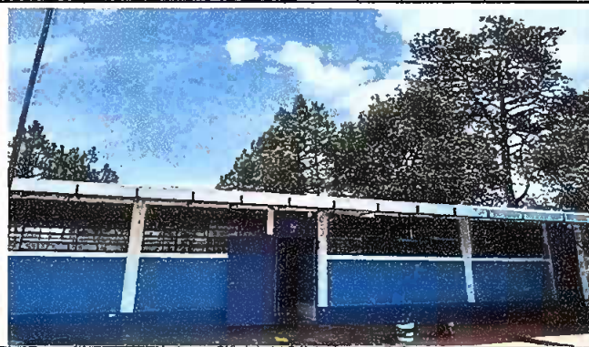
Foto 2: Modulo 1 Sustitución de canal de PVC Renglon 7.2
