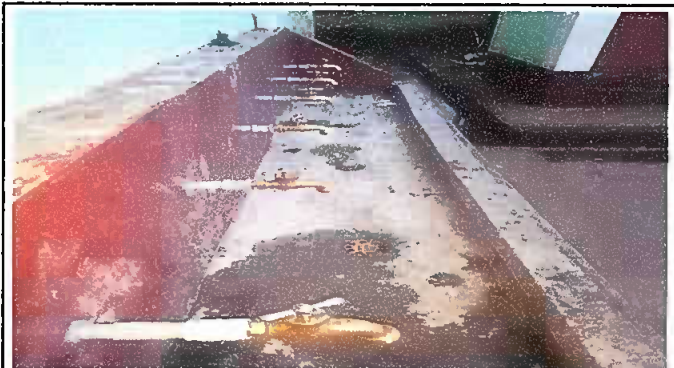
Foto 6: Modulo 2 Instalación de llave de Chorro Renglon 14.13
