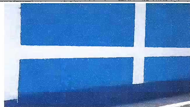
Foto 5: Modulo 4 Reparación de muro perimetral de block Renglon 15.1
