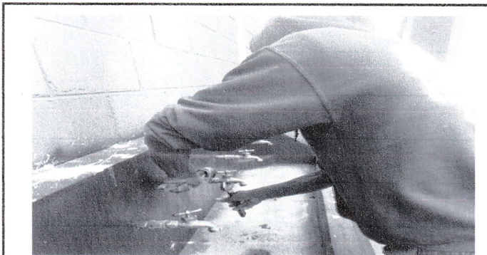
Foto 6: Modulo 2 Instalación de llave de Chorro Renglon 14.13
