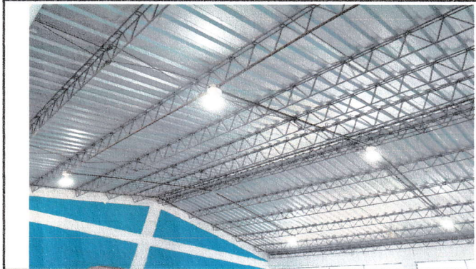
Foto1: Modulo 1 y 2 Sustitución de lamparas tipo LED Renglon 17.3
