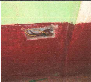
Foto 5: Renglon 6. Modulo 1 Sustitución de toma corrientes dobles
