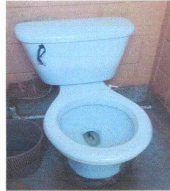
Foto 8: Renglon 25. Modulo 3 Sustitución de accesorios inodoro (contra llave, tubo de abasto y tanque)
