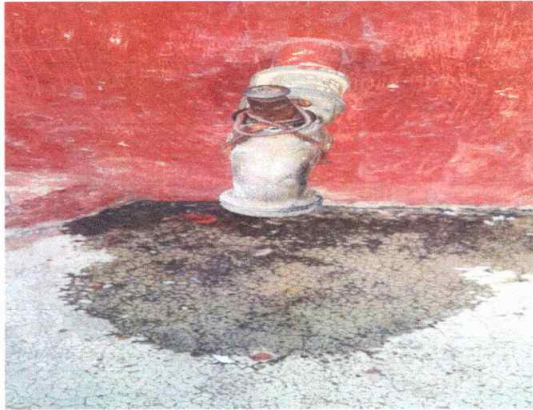
Foto 7: Renglon 19. Modulo 2 Sustitución de llave de chorro
