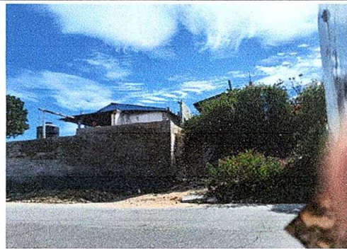
Foto 6: reparación muro de contención
