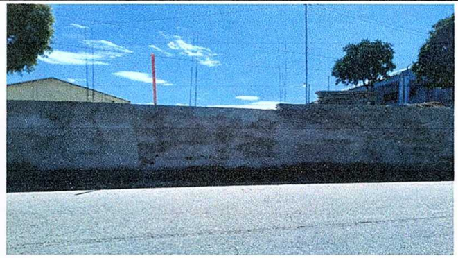
Foto 2: reparación de muro de contención
