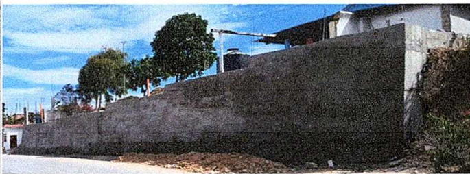
Foto 5: reparación de muro de contención
