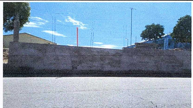
Foto 4: reparación de muro de contención
