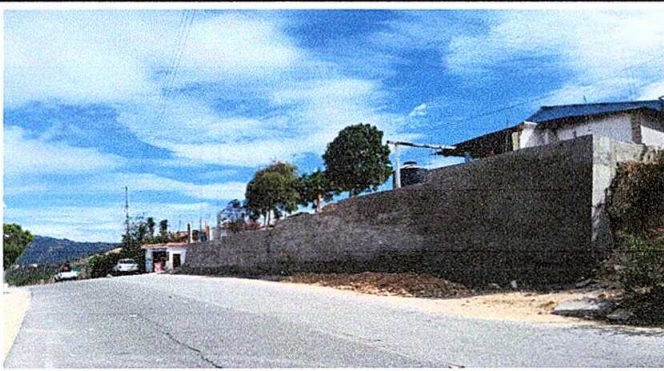
Foto 3: reparación de muro de contención
