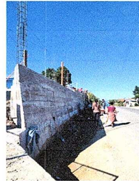
Foto 4: reparación de muro de contención
