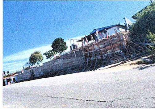
Foto 6: reparación muro de contención
