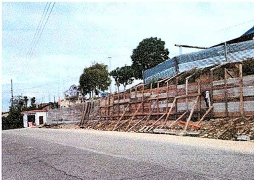
Foto 5: reparación de muro de contención
