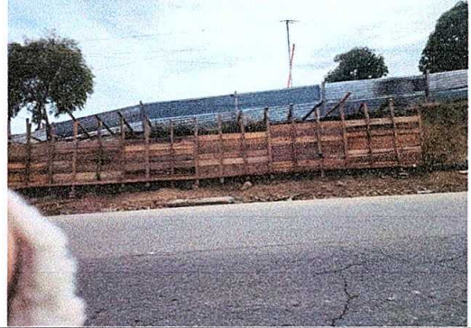
Foto 2: reparación de muro de contención
