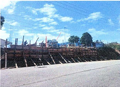
Foto 3: reparación de muro de contención
