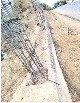
Foto 1: Reparación de muro de contención
