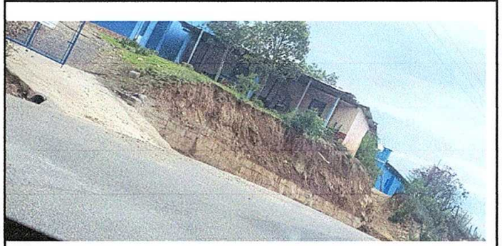
Foto 4: reparacion de muro de contension
