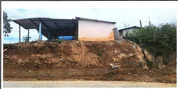
Foto 3: reparacion de muro de contension
