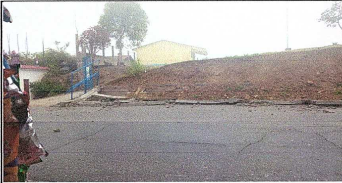
Foto1: Reparacion de muro de contension
