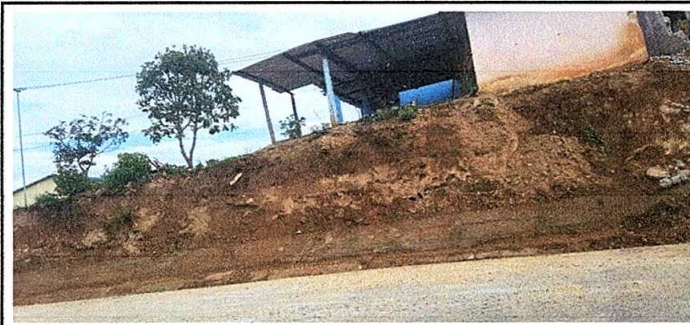
Foto 5: reparacion de muro de contension
