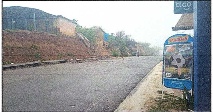
Foto 2: reparacion de muro de contension
