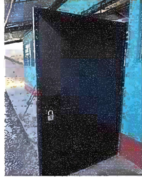
Foto 8: Módulo 1 Estructura de puertas realizado
