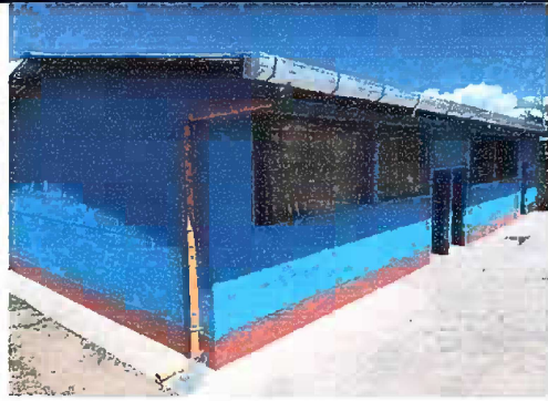
Foto 6: Módulo 1 Sustitución de canal terminado
