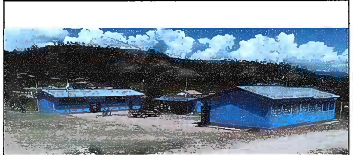
Foto 12: Pintura general de muros interior y exterior terminado
