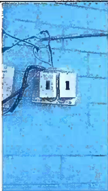
Foto 3: Módulo 1 Sustitución de flipón realizado
