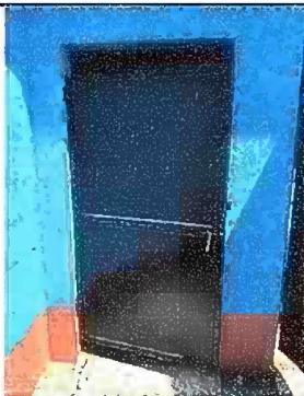
Foto 11: Módulo 3 Proceso de mantenimiento a estructura de puertas
