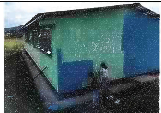
Foto 12: Proceso de pintura general de muros interior y exterior
