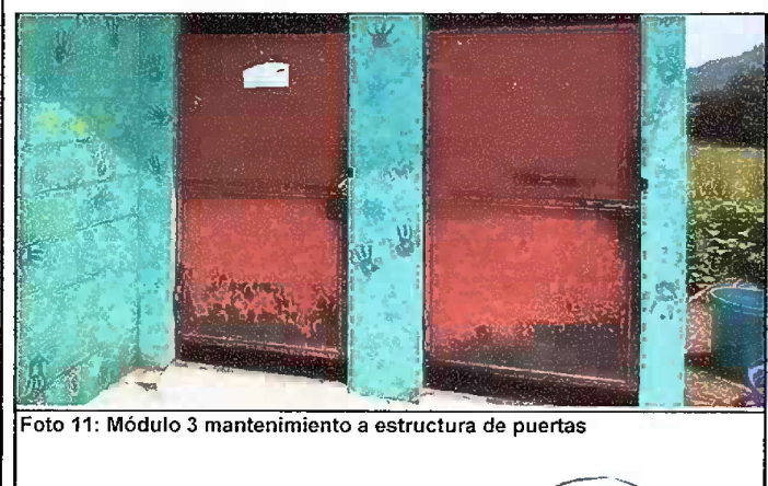
Foto 11: Módulo 3 mantenimiento a estructura de puertas
