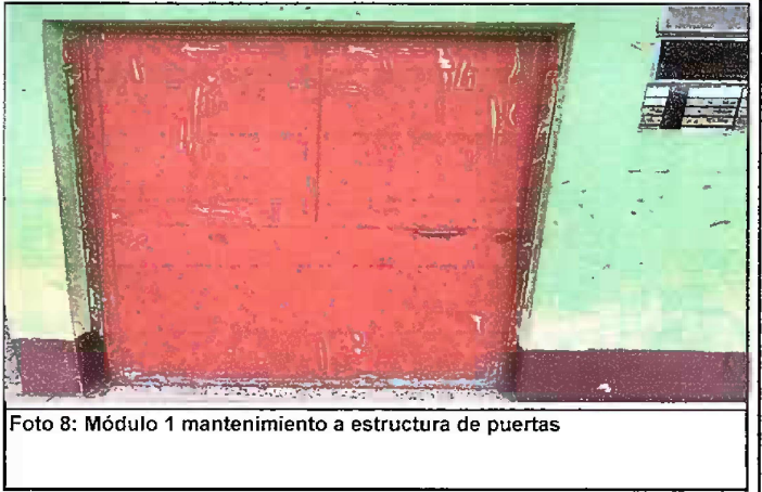
Foto 8: Módulo 1 mantenimiento a estructura de puertas
