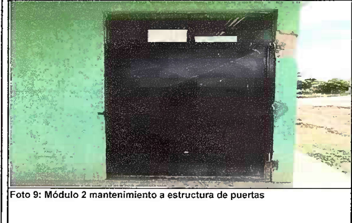
Foto 9: Módulo 2 mantenimiento a estructura de puertas
