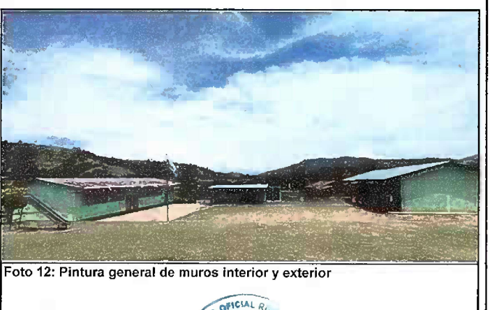
Foto 12: Pintura general de muros interior y exterior
