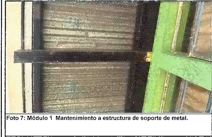
Foto 7: Módulo 1 Mantenimiento a estructura de soporte de metal.
