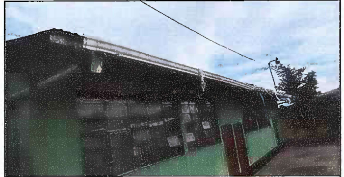
Foto 6: Módulo 1 Sustitución de canal.
