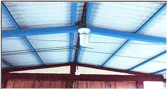
Foto 12: Reparación de cableado eléctrico general
