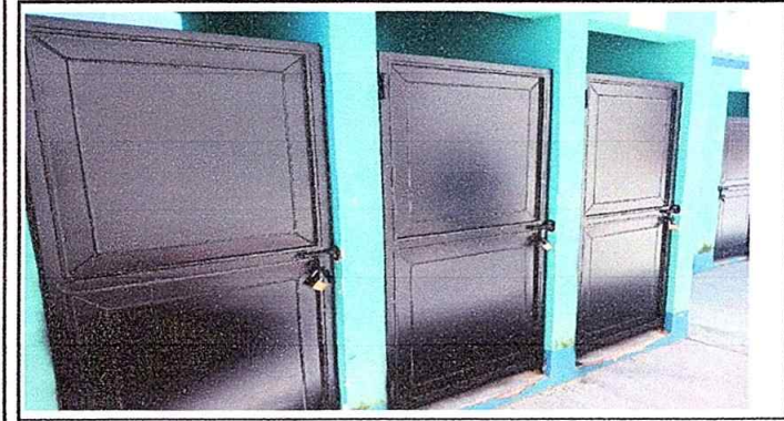
Foto1: Módulo 1 Sustitución de puertas
