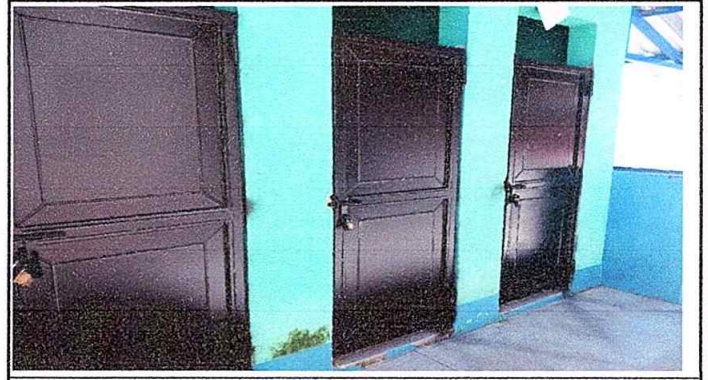
Foto 2: Módulo 2 Sustitución de puertas
