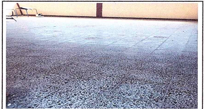
Foto 4: Módulo 3 Sustitución de piso
