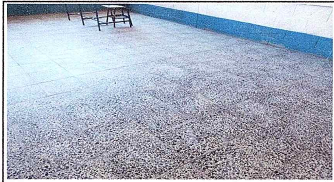
Foto 10: MÓDULO 7 Sustitución de piso
