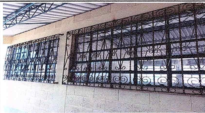
Foto 9: MÓDULO 7 Suministro e intalación de Balcones
