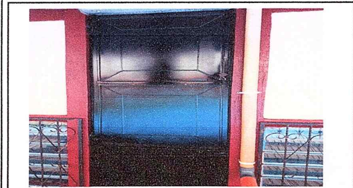
Foto 3: Modulo 3 Sustitución de puertas
