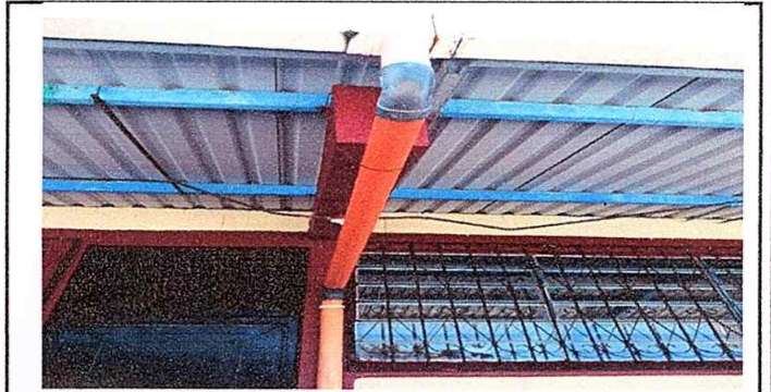
Foto 6: MÓDULO 3 Reparación de bajadas de agua pluvial
