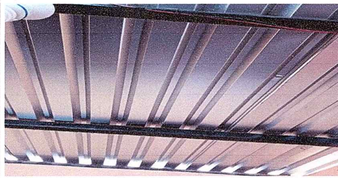
Foto 7: MÓDULO 5 Sustitución de lámina por lámina troquelada
