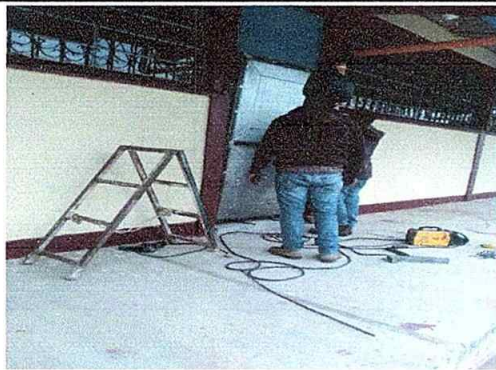
Foto 3: Módulo 3 Sustitución de puertas
