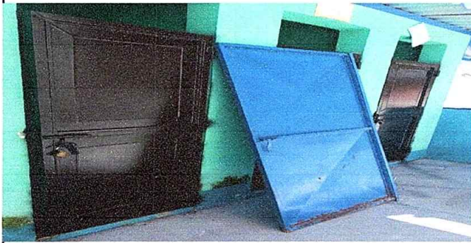
Foto 1: Módulo 1 Sustitución de puertas
