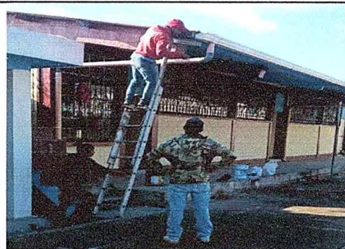
Foto 6: MÓDULO 3 Reparación de bajadas de agua pluvial
