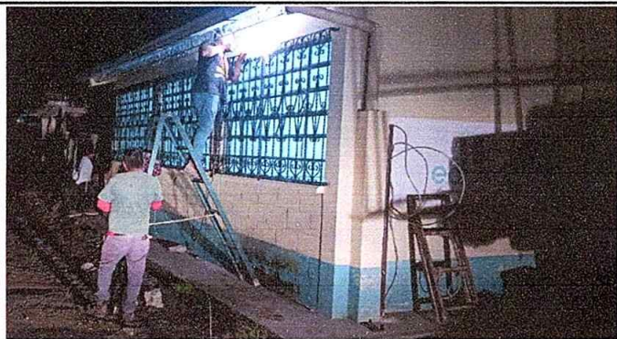
Foto 9: MÓDULO 7 Suministro e intalación de Balcones
