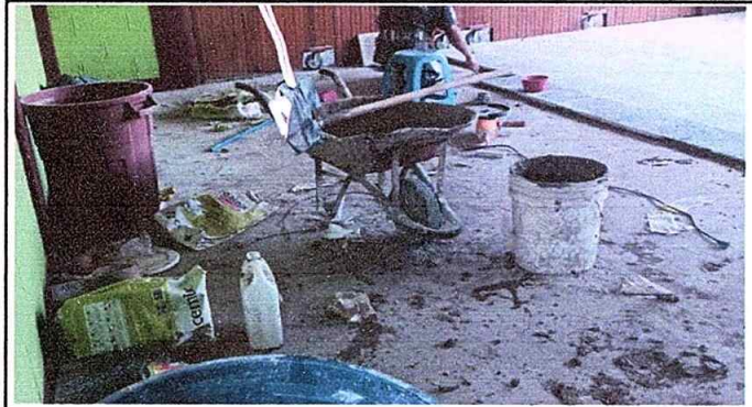
Foto 4: Módulo 3 Sustitución de piso
