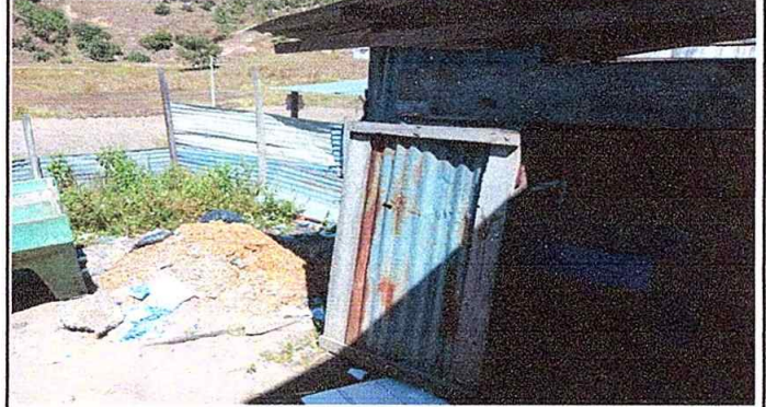
Foto 8: MÓDULO 6 Sustrucción de Pila
