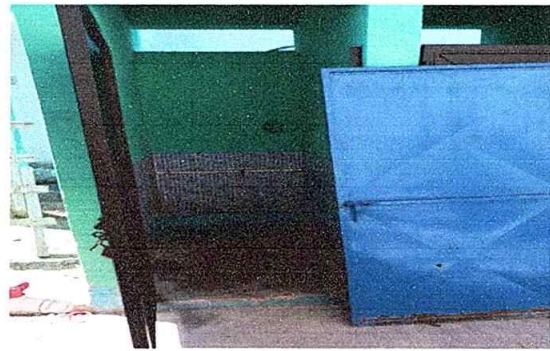
Foto 2: Módulo 2 Sustitución de puertas
