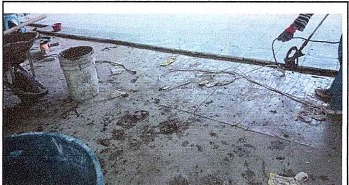
Foto 10: MÓDULO 7 Sustrucción de piso
