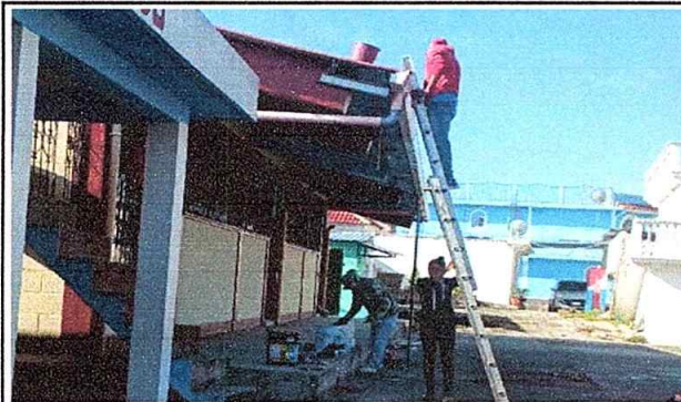
Foto 5: MÓDULO 3 Reparación de canales
