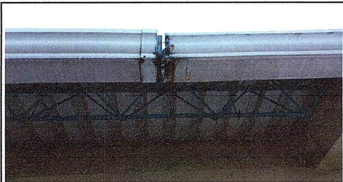
Foto 11: MÓDUO 7 Reparación de canales
