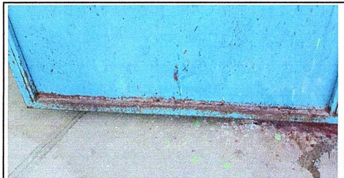
Foto 3: Modulo 3 Sustrucción de puertas
