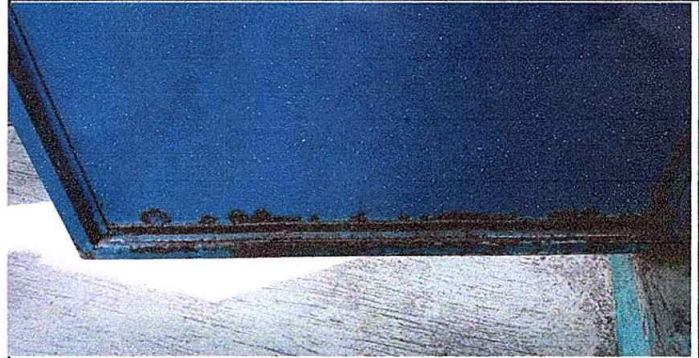
Foto 2: Módulo 2 Sustrucción de puertas
