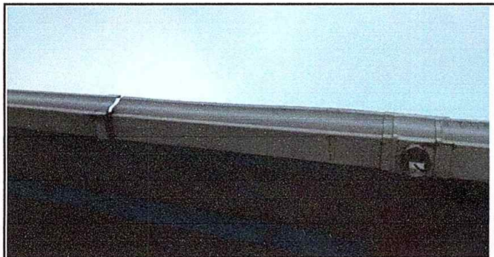
Foto 5: MÓDULO 3 Reparación de canales
