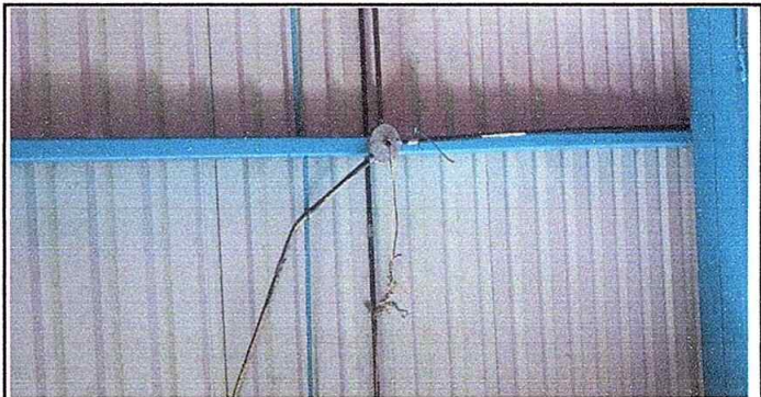
Foto 12: MÓDUO 7 Reparación de cableado eléctrico general
