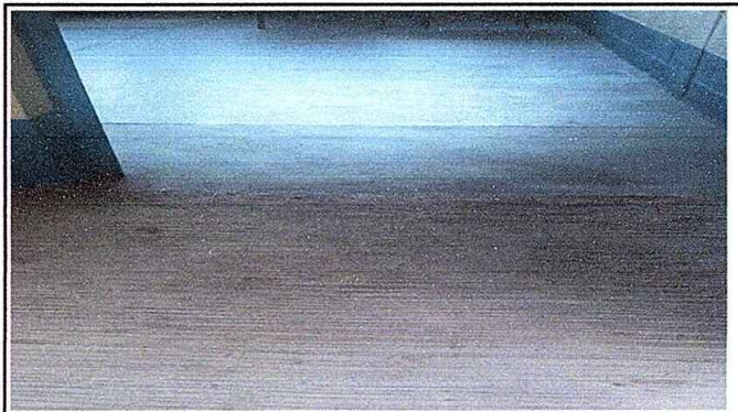
Foto 10: MÓDUO 7 Sustitución de piso
