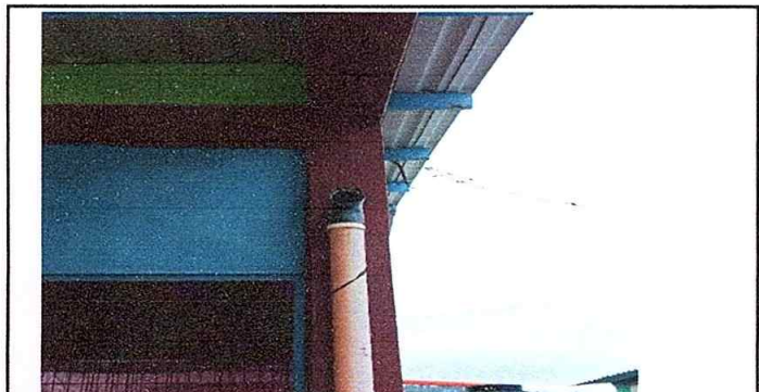
Foto 6: MÓDULO 3 Reparación de bajadas de agua pluvial
