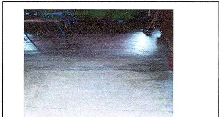
Foto 4: Módulo 3 Sustrucción de piso
