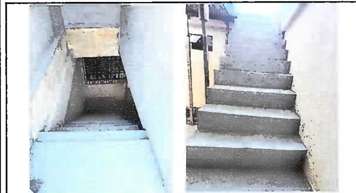
Foto 1: Sustitución de gradas de madera por gradas de concreto
