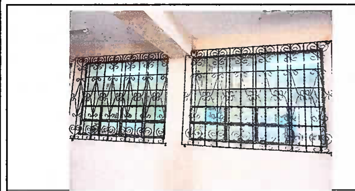
Foto 5: fabricación e instalación de balcones
