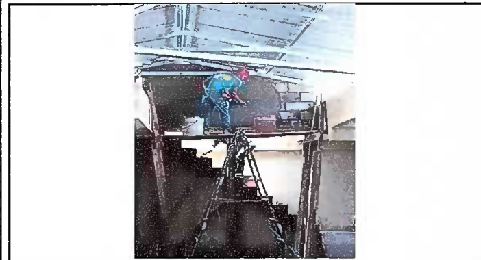
Foto 3: Reparación de muro de block
