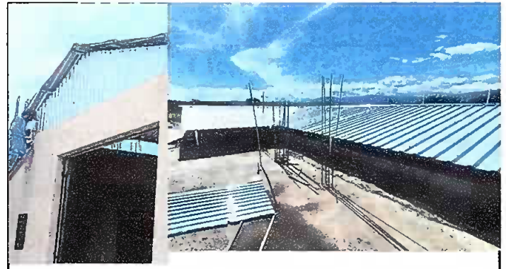
Foto 4: Sustitución de estructura de metal y lámina por estructura de metal y lamina troquelada aluzinc calibre 26
