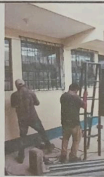
Foto 6: fabricación e instalación de balcones
