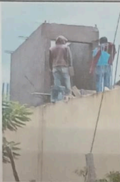
Foto 3: Reparación de muro de block
