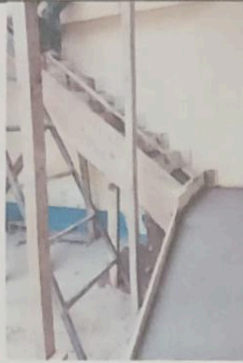
Foto 1: Sustitución de gradas de madera por gradas de concreto
