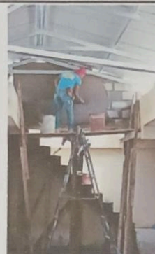
Foto 2: Reparación de muro de block
