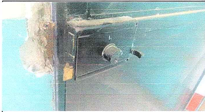
Foto 4.2: PUERTAS, Sustitución de Chapas
