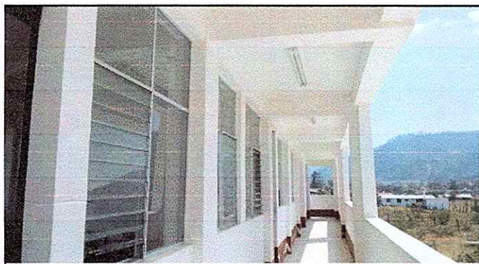
Foto 6.9: Mantenimiento de piso de granito (pulido y lustrado), de todo el modulo conformado por cuatro aulas, una dirección. Un baño para caballeros, y un baño para damas. Corredores y las gradas.
