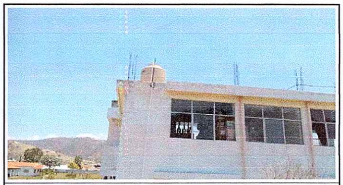
foto 18.3: sustitución de depósito de agua a 1700 lts. Ya que la población estudiantil es bastante y no es suficiente lo que se cuenta en la actualidad, y por la escases de agua.
