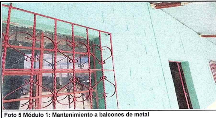
Foto 5 Módulo 1: Mantenimiento a balcones de metal
