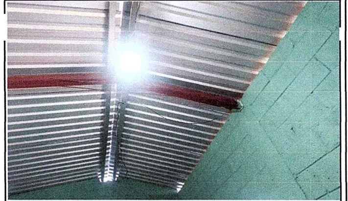
Foto 8 Módulo 1: Reparación de lámparas
