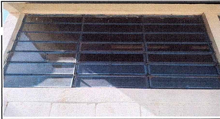
Foto 9 Módulo 2: sustitución de vidrios
