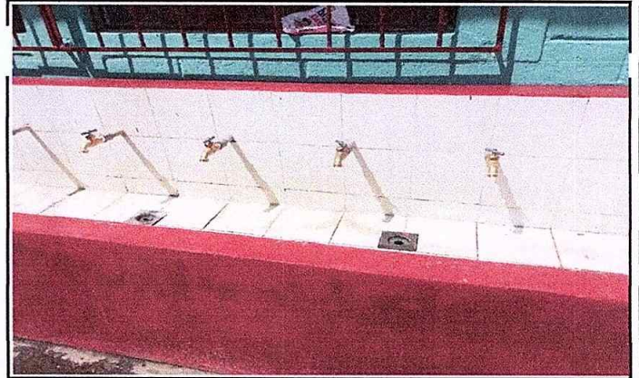
Foto 14 Módulo 3: Sustitución de llave de chorro
