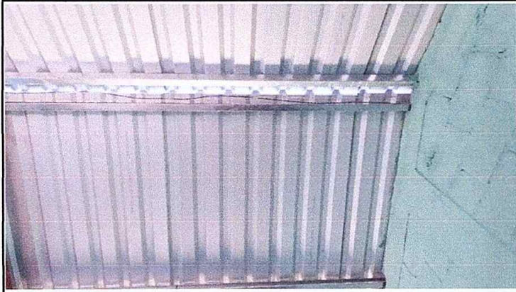
Foto 7 Módulo 1: Reparación de cableado eléctrico
