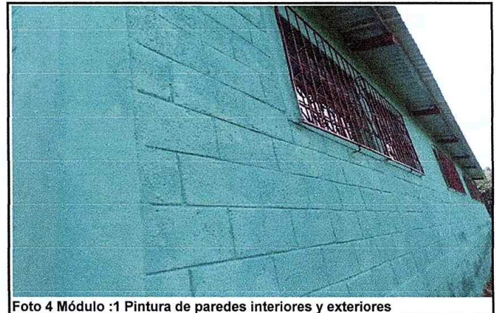
Foto 4 Módulo 1: Pintura de paredes interiores y exteriores
