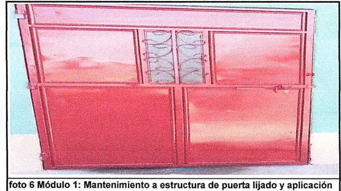
Foto 6 Módulo 1: Mantenimiento a estructura de puerta lijado y aplicación
