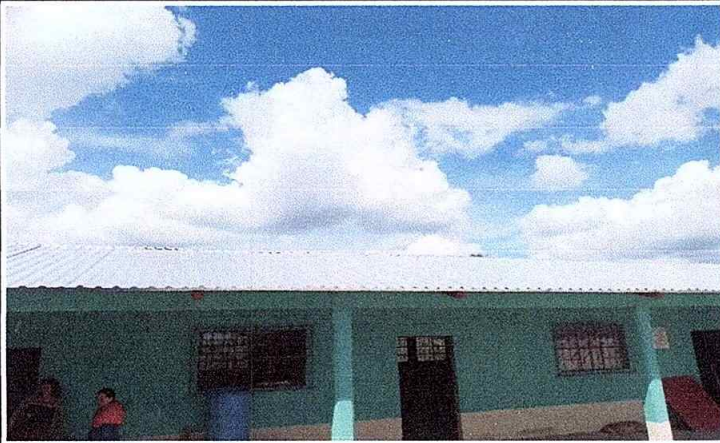
Foto 1 Módulo 1: Sustitución de lámina por lámina troquelada aluzinc cal 26
