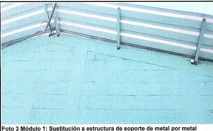
Foto 3 Módulo 1: Sustitución a estructura de soporte de metal por metal
