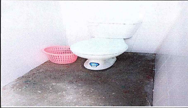
Foto 13 Módulo 3: Sustitución de inodoros
