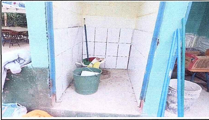
Foto 13 Módulo 3: Sustitución de inodoros
