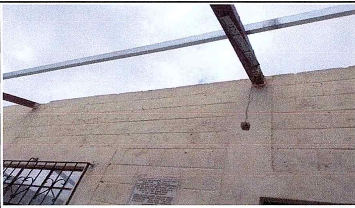
Foto 3 Módulo 1: Sustitución a estructura de soporte de metal por metal
