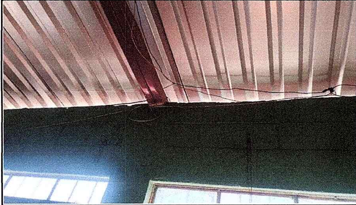
Foto 7 Módulo 1: Reparación de cableado eléctrico
