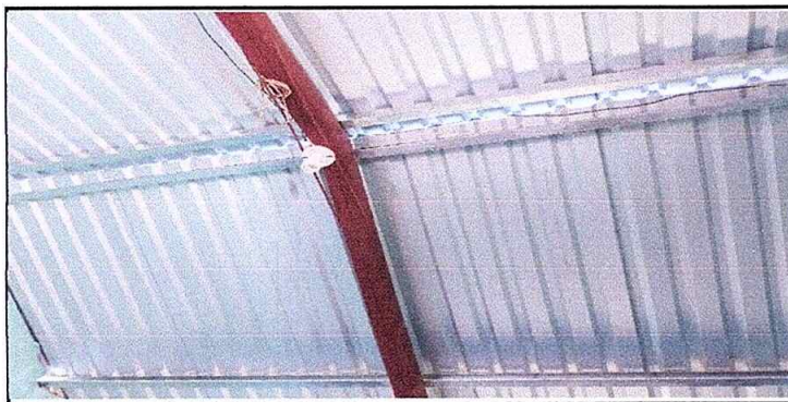
Foto 11 Módulo 2: Reparación de cableado eléctrico
