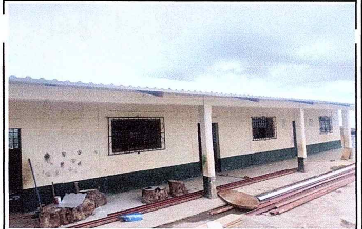
Foto 2 Módulo 1: Sustitución de capote para lámina troquelada
