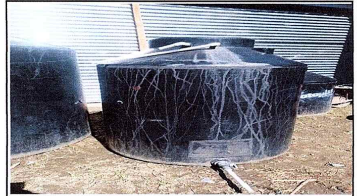
foto 16 Módulo 3: Sustitución de depósito de agua No. 1 (1700 LTS)
