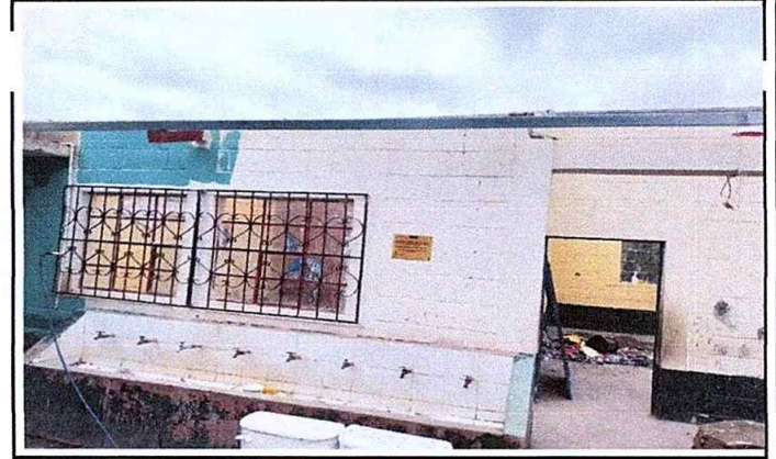
Foto 14 Módulo 3: Sustitución de llave de chorro
