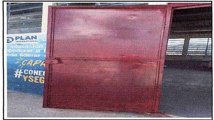
Foto 10 Módulo 2: mantenimiento a estructura de puerta lijado y aplicación de pintura
