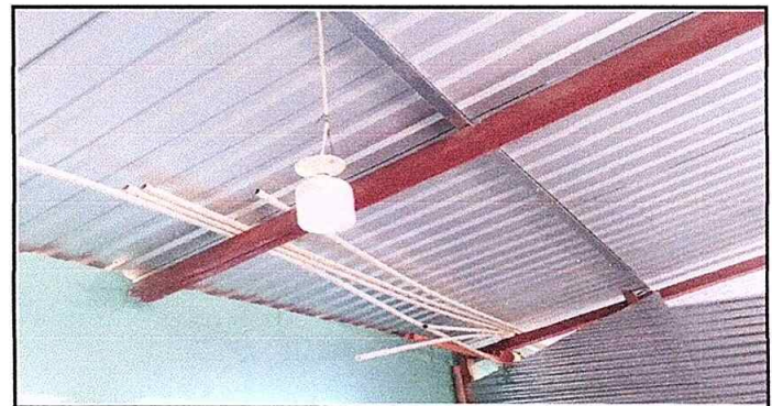
Foto 12 Módulo 2: Reparación de lámparas
