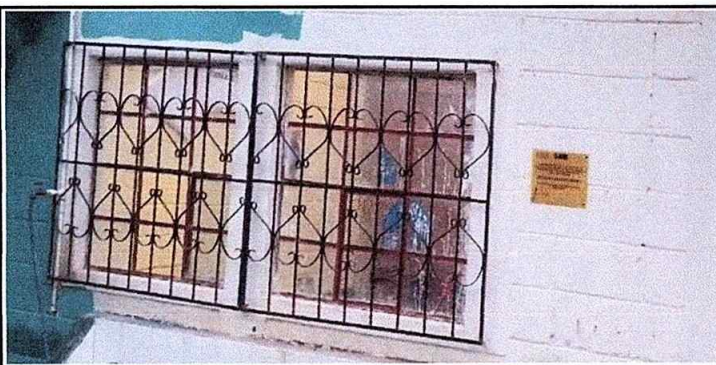
Foto 5 Módulo 1: Mantenimiento a balcones de metal
