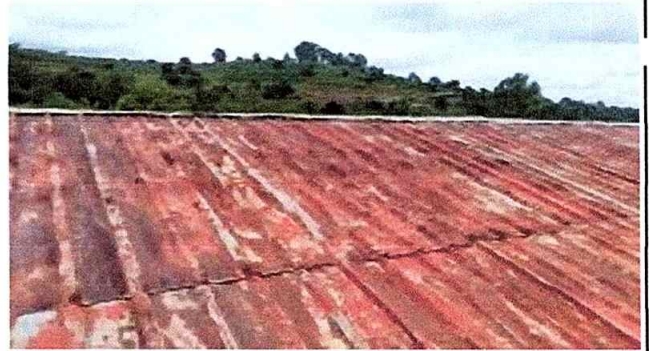
Foto 2 Módulo 1: Sustitución de capote para lámina troquelada
