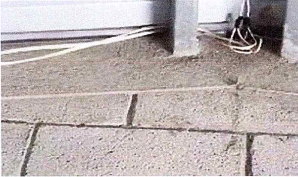
Foto 7 Módulo 1: Reparación de cableado eléctrico
