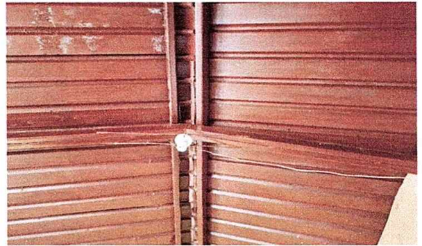
Foto 8 Módulo 1: Reparación de lámparas
