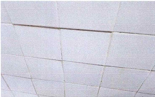
Foto 15 Módulo 3: Sustitución de azulejos
