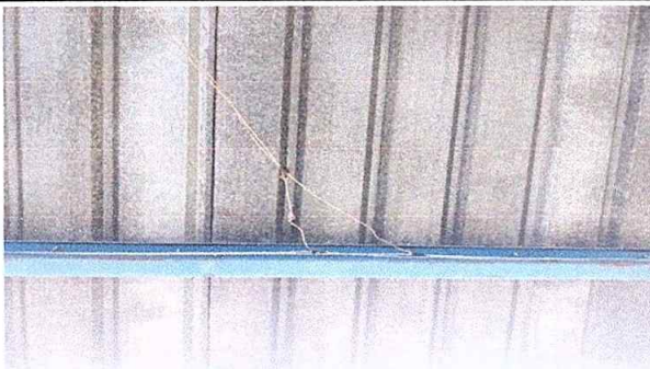
Foto 11 Módulo 2: Reparación de cableado eléctrico
