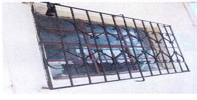
Foto 5 Módulo 1: Mantenimiento a balcones de metal
