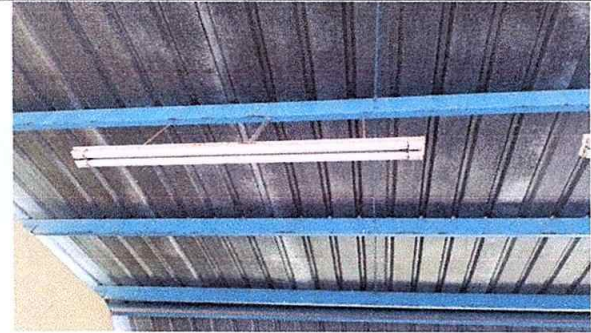
Foto 12 Módulo 2: Reparación de lámparas
