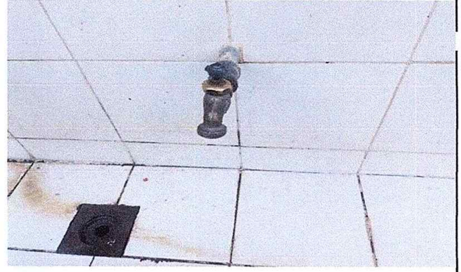
Foto 14 Módulo 3: Sustitución de llave de chorro
