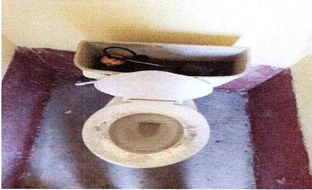
Foto 13 Módulo 3: Sustitución de inodoros
