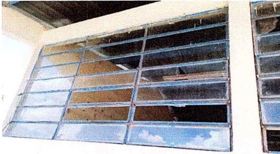
Foto 9 Módulo 2: sustitución de vidrios
