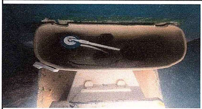
modulo 4: fot.3 Sustitucion de accesorio inodoro. (contrallave, tubo de abasto y tanque)
