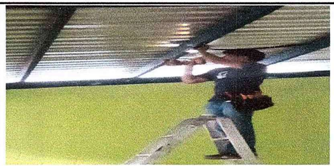
Modulo 3: foto2 sustitucion de lámparas 2x20, reparación de cableado eléctrico, instalacion de unidades de luz.
