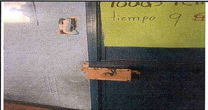
Modulo 3: foto 6 Sustitucion de chapa y mantenimiento a estructura.
