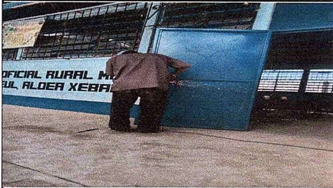
MODULO1. foto7. Sustitucion de Chapa y mantenimiento a estructura de puerta.
