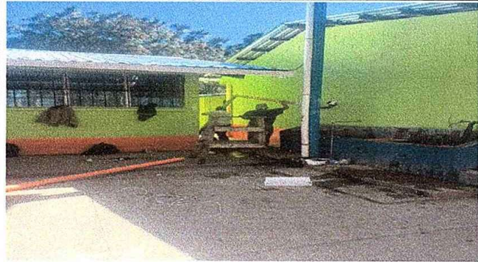
modulo 3: foto3 Sustitución de canal pvc y reparación de bajada de agua pluvial, tubo pvc 3
