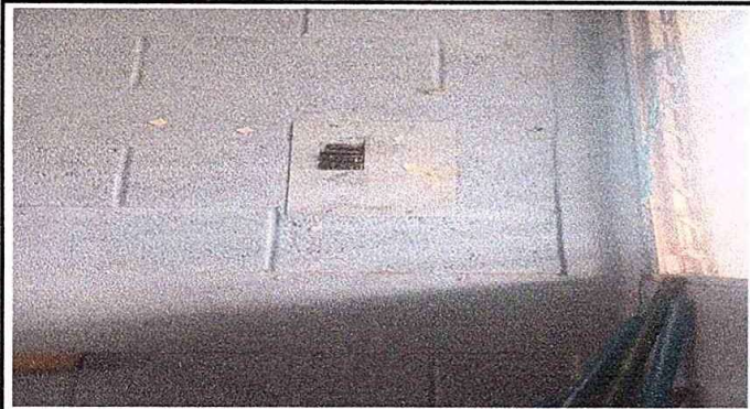
modulo 3. foto. 5 sustitucion de tablero de flifones e instalacion de flifones
