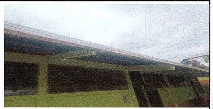
Modulo 2: foto. 1 Sustitución de canal pvc y reparación de bajada de agua pluvial pvc 3.
