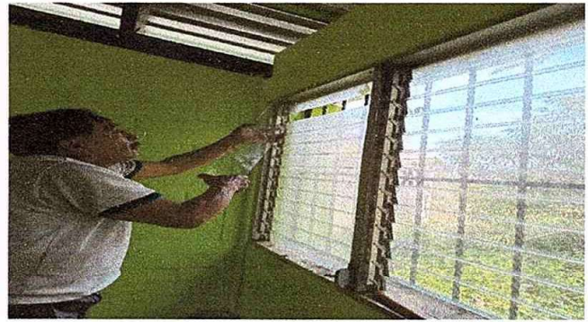
Modulo 3: foto4 sustitucion de vidrios.
