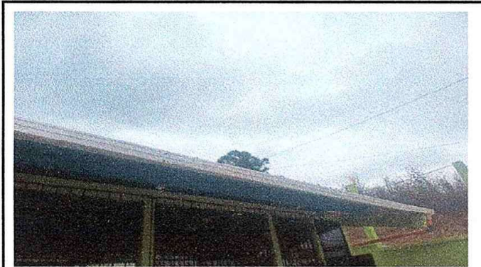
modulo 1: Foto 3. Sustitucion de canal pvc.
