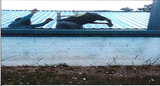
Modulo 1: Foto. 1 Sustitucion de lámina, por lámina troquelada al zinc calibre 26, sustitución de capote de lámina y sustitucion de elementos de fijación (tornillos)
