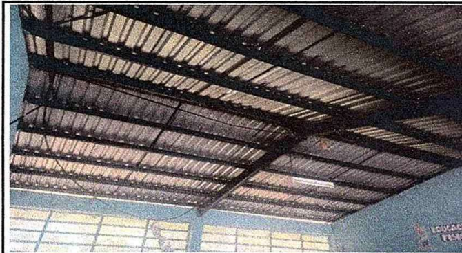
Modulo 2: foto. 2sustitucion de lámpara de 2x40, reparación de cableado eléctrico e instalación de unidades luz.
