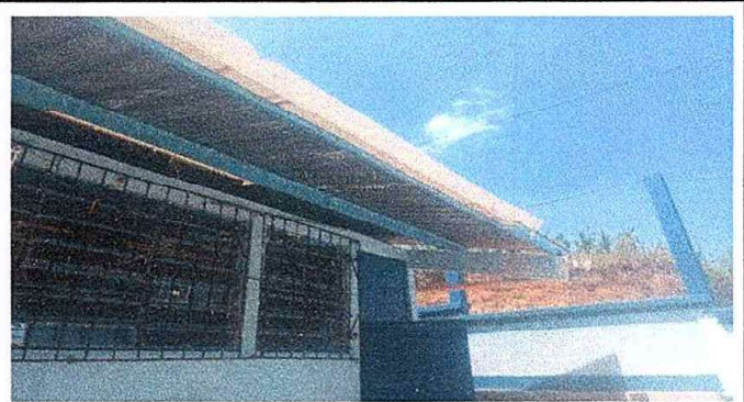
Modulo 1: Foto 2. Mantenimiento a balcones de metal.
