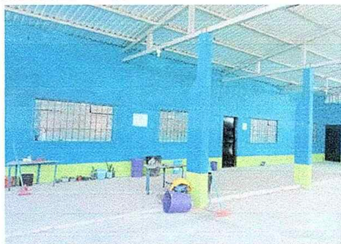
Foto No. 5, Módulo No. 1. Pintura de muros interiores y exteriores
