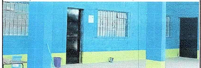
Foto No. 6, Módulo No. 1. Mantenimiento a estructura de puerta (lijado, cambio de tubo. Cepillado, sujeción, aplicación de pintura
