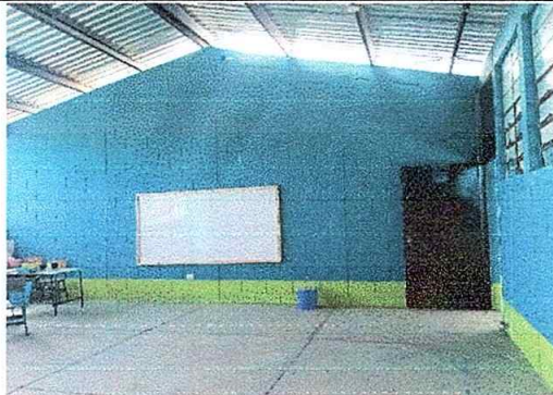
Foto No.9, Módulo No. 2. Sustitución de lámina, por lámina troquelada
