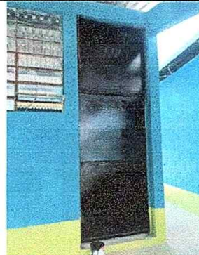
Foto No. 10, Módulo No. 2. Mantenimiento a estructura de puerta (lijado, cambio de tubo) Cepillado, sujeción, aplicación de pintura
