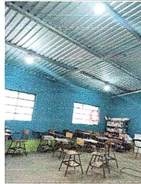
Foto No. 2, Módulo No. 1. Reparación de cableado eléctrico, sustitución ducto electrico más accesorios, sustitución de tomacorrientes, sustitución de focos ahorradores, mantenimiento a estructura de puerta (lijado, cepillado)
