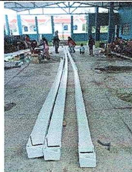
Foto No. 12, Módulo No. 2. Sustitución de canal de canal pvc.
