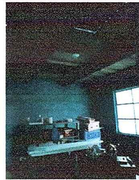
Foto No. 4, Módulo No. 1. Sustitución de vidrios
