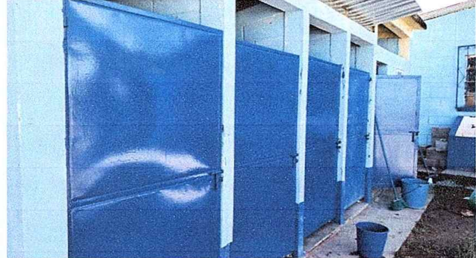
Foto 2: MÓDULO 1 MANTENIMIENTO DE PUERTAS
