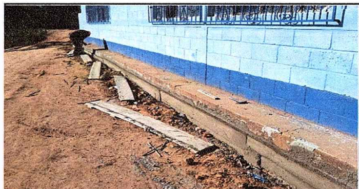
Foto 6: MÓDULO 4 MANTENIMIENTO DE BANQUETA DE CEMENTO
