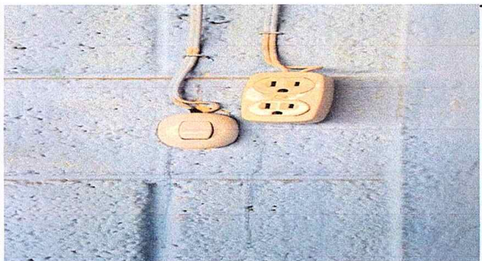
Foto 3: MÓDULO 4 SUSTITUCION DE TOMACORRIENTES
