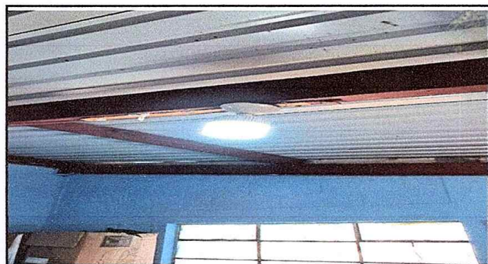
Foto 4: MÓDULO 4 SUSTITUCION DE FOCOS AHORRADORES
