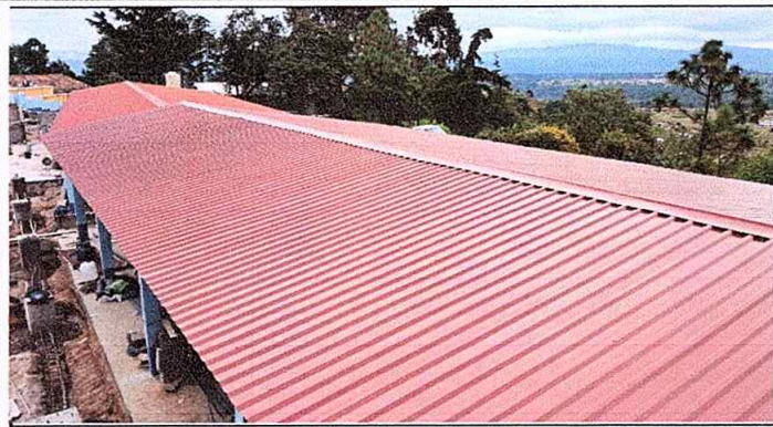
Foto1: MÓDULO 4. SUSTITUCIÓN DE CAPOTE DE LAMINA POR CAPOTE DE LAMINA TROQUELADA CALIBRE 26
