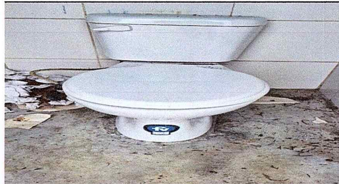
Foto 4: MÓDULO 1 SUSTITUCION DE SANITARIOS
