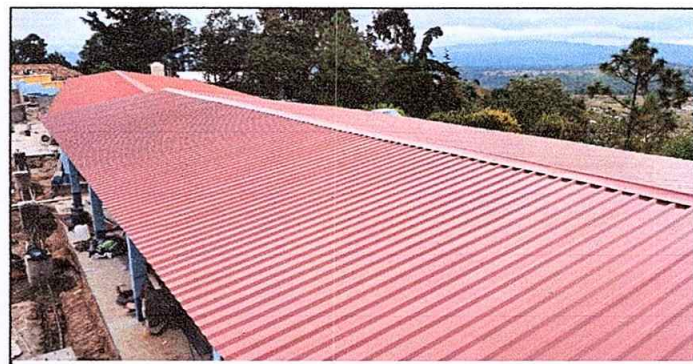
Foto 6: MÓDULO 4 SUSSTITUCION DE LAMINA POR LAMINA TROQUELADA ALUZICN CALIBRE 26 COLOR ROJO
