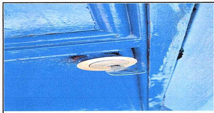
Foto 5: MÓDULO 4 SUSTITUCION DE CHAPA DE PUERTA DE METAL
