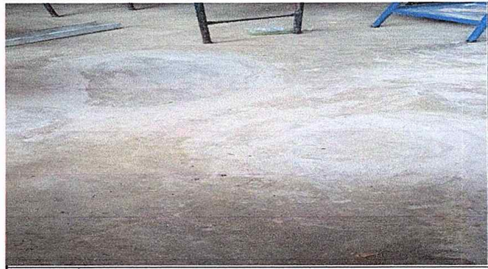
Foto 2: MÓDULO 4 REPARACION DE PISO TORTA DE CEMENTO
