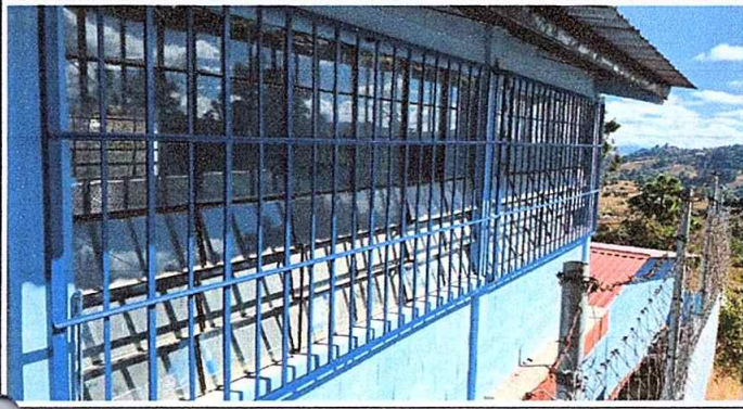
Foto 1: INSTALACION DE BALCONES
