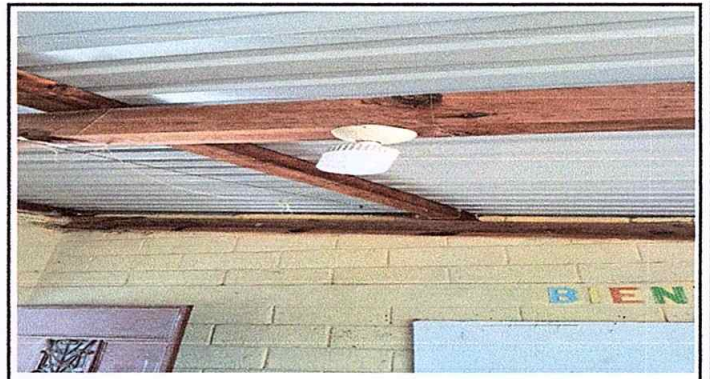
Foto 4: MÓDULO 4 SUSTITUCION DE FOCOS AHORRADORES
