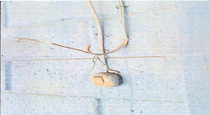
Foto 3: MÓDULO 4 SUSTITUCION DE TOMACORRIENTES
