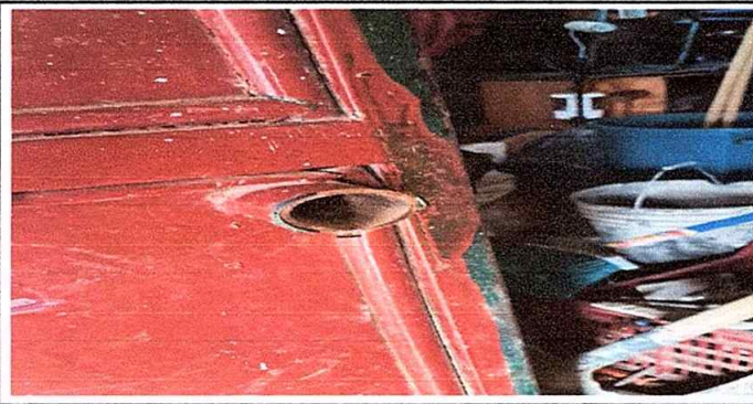
Foto 5: MÓDULO 4 SUSTITUCION DE CHAPA DE PUERTA DE METAL
