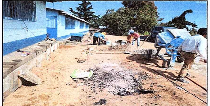
Foto 6: MÓDULO 4 MANTENIMIENTO DE BANQUETA DE CEMENTO
