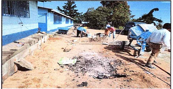
Foto 6: MÓDULO 4 MANTENIMIENTO DE BANQUETA DE CEMENTO
