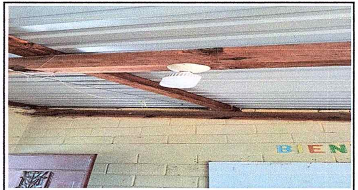
Foto 4: MÓDULO 4 SUSTITUCION DE FOCOS AHORRADORES
