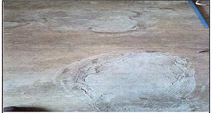
Foto 2: MÓDULO 4 REPARACION DE PISO TORTA DE CEMENTO
