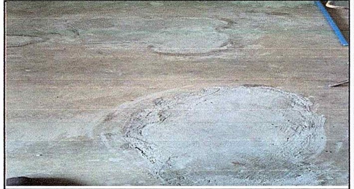
Foto 2: MÓDULO 4 REPARACION DE PISO TORTA DE CEMENTO
