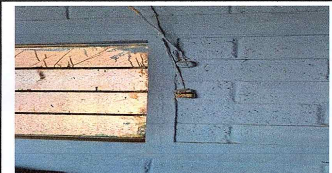
Foto 3: MÓDULO 4 SUSTITUCION DE TOMACORRIENTES
