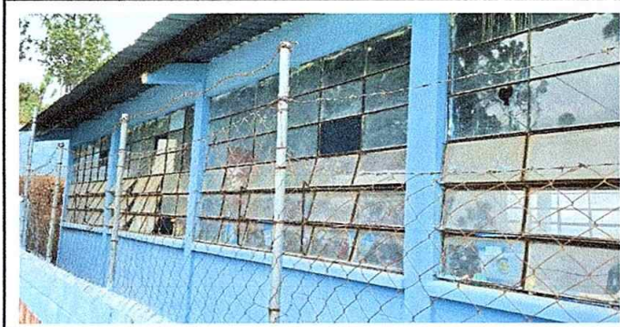
Foto 1: MÓDULO 5 REPARACIÓN DE MURO PERIMETRAL
