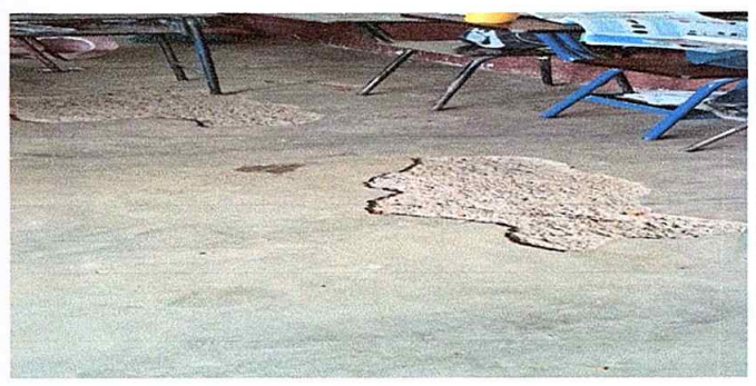
Foto 2: MÓDULO 4 REPARACION DE PISO TORTA DE CEMENTO
