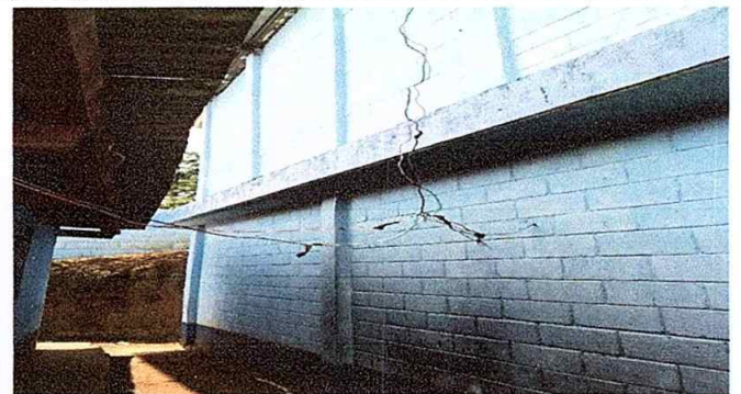
Foto 2: MÓDULO 5 REPACION DE CABLEADO ELECTRICO
