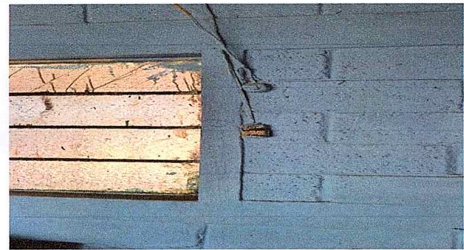
Foto 3: MÓDULO 4 SUSTITUCION DE TOMACORRIENTES
