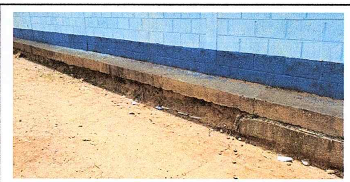
Foto 6: MÓDULO 4 MANTENIMIENTO DE BANQUETA DE CEMENTO
