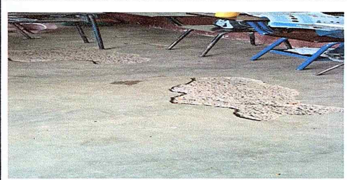
Foto 2: MÓDULO 4 REPARACION DE PISO TORTA DE CEMENTO
