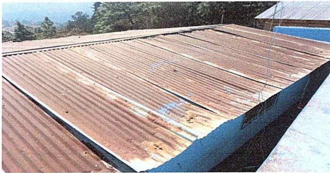
Foto 1: MÓDULO 4. SUSTITUCIÓN DE CAPOTE DE LAMINA POR CAPOTE DE LAMINA TROQUELADA CALIBRE 26
