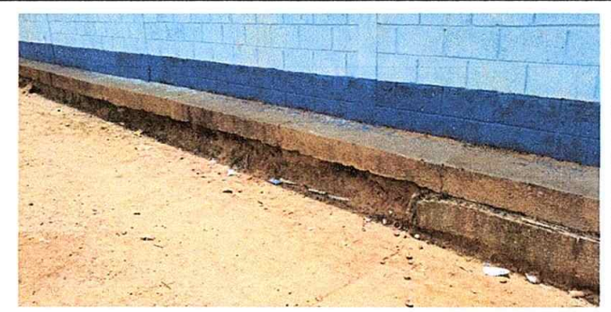
Foto 6: MÓDULO 4 MANTENIMIENTO DE BANQUETA DE CEMENTO
