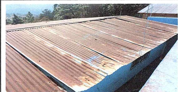
Foto1: MÓDULO 4. SUSTITUCIÓN DE CAPOTE DE LAMINA POR CAPOTE DE LAMINA TROQUELADA CALIBRE 26
