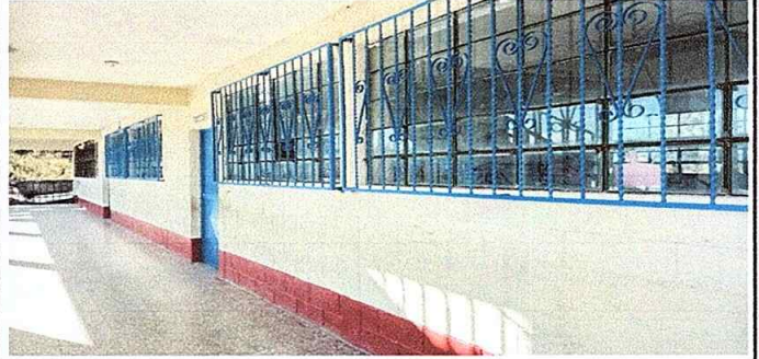
Foto 8: Modulo 2. Suministro e instalación de balcones de hierro en ventanas.
