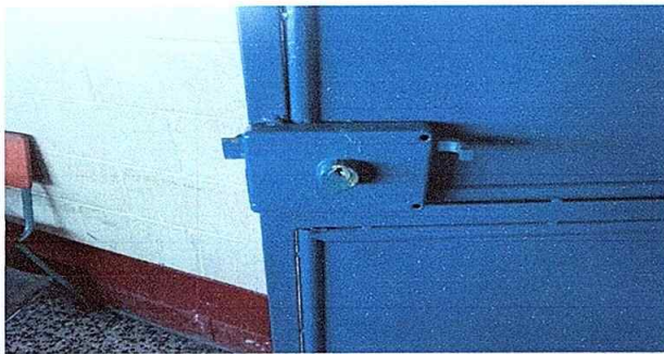
foto 9. Modulo : 2. Sustitución de Chapa.
