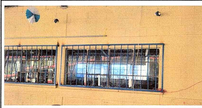
Foto 5: Modulo 2. Sustitución de vidrios.
