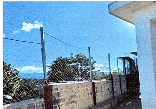
Foto 2: MURO PERIMETRAL. Reparación de tubos hg y malla galvanizada.
