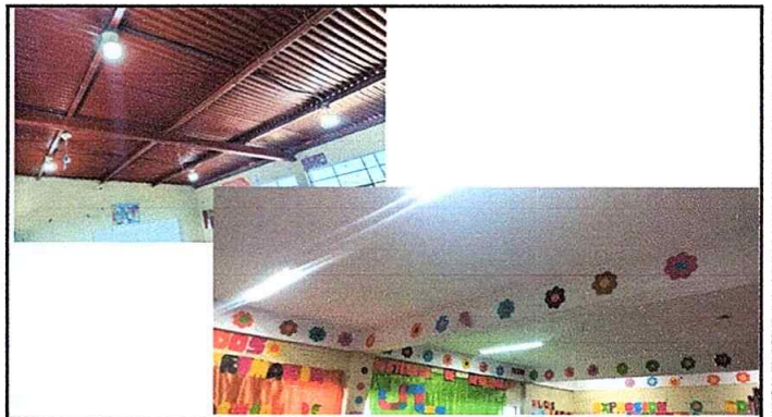
Foto 4: Modulo 2. Sustitución de focos ahorradores y sustitución de lamparas tipo led.
