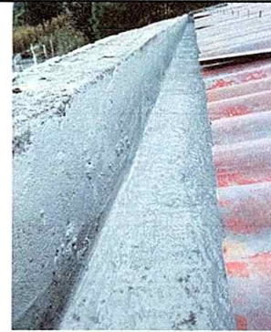
Foto 6: Modulo 2. Impermeabilización de paredes (canales de concreto para no filtrar el agua.
