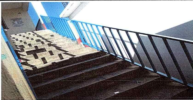
Foto 11. Modulo 2. Mantenimiento de barandas de metal.
