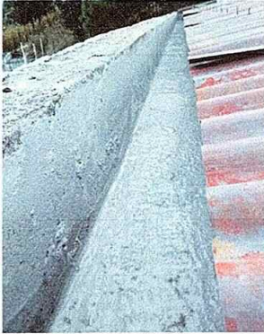
Foto 7: Modulo 2. Reparación de bajada de agua pluvial e impermeabilización.
