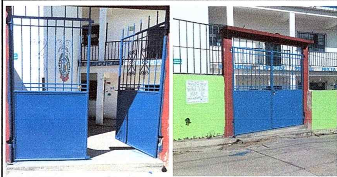
Foto 3: MURO PERIMETRAL: Mantenimiento de portón de metal.
