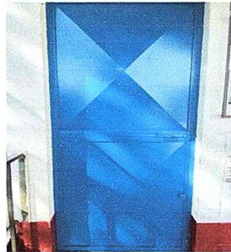
Foto 10. Modulo 2. Mantenimiento de estructura de puerta.
