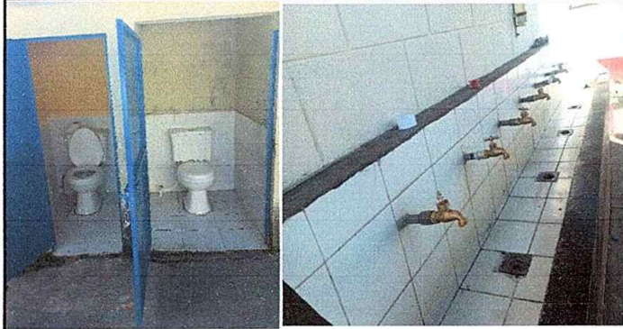
Foto1: Modulo 1. Sustitución de inodoros, sustitución de chorros y sustitución de azulejos.
