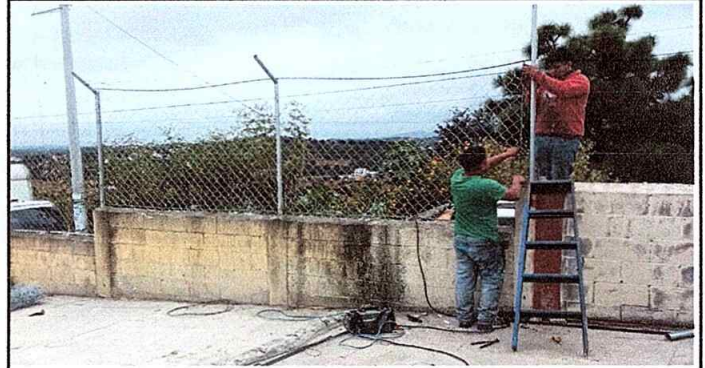
Foto 2: MURO PERIMETRAL. Reparación de tubos hg y malla galvanizada.
