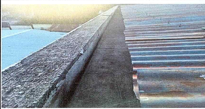
Foto 7: Modulo 2. Reparación de bajada de agua pluvial, limpieza, no hubo necesidad sustituir tubo pvc
