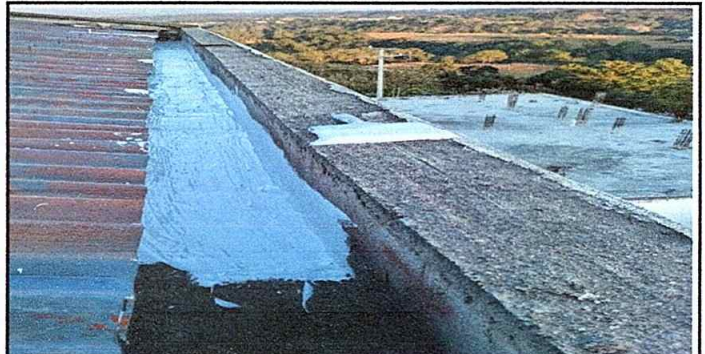
Foto 6: Modulo 2. Impermeabilización de pared. Se impermeabilizó el canal de concreto, para que no filtre agua.
