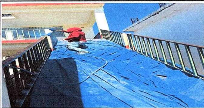
Foto 11. Modulo 2. Mantenimiento de barandas de metal.
