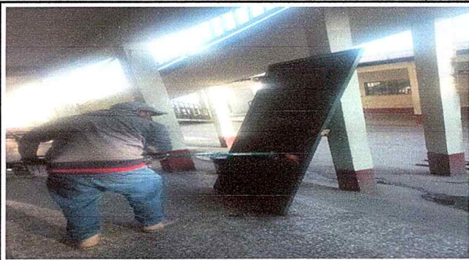
foto 9. Modulo : 2. Sustitución de Chapa.
