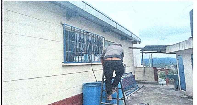
Foto 8: Modulo 2. Suministro e instalación de balcones de hierro en ventanas.
