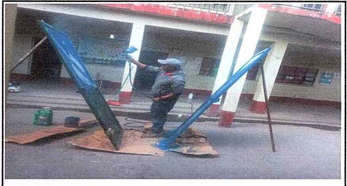
Foto 10. Modulo 2. Mantenimiento de estructura de puerta.
