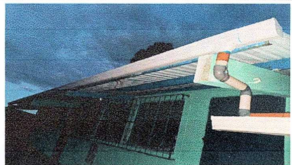
Foto 6: Modulo . Sustitución de canales de pvc
