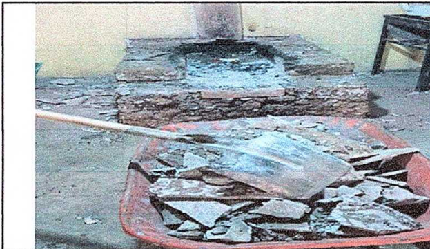
Foto 5: Modulo 5. Sustitución de plancha de metal de 3 ornillas
