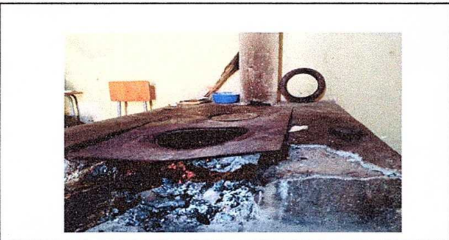
Foto 5: Modulo 3. Sustitución de plancha de metal de 3 ornillas
