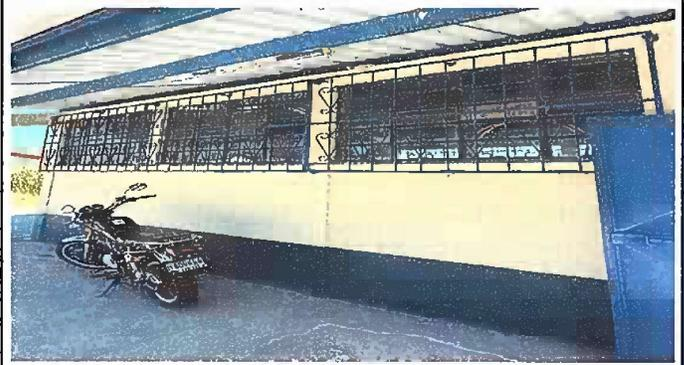
Foto 2. Modulo 1: Suministro e instalación de balcon de hierro en ventana
