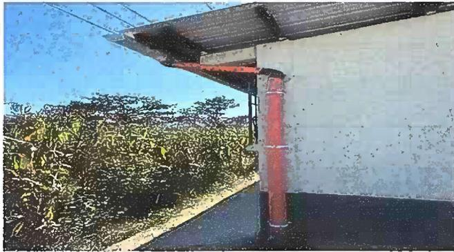
Foto 1. Modulo1: Sustitución de canales de PVC
